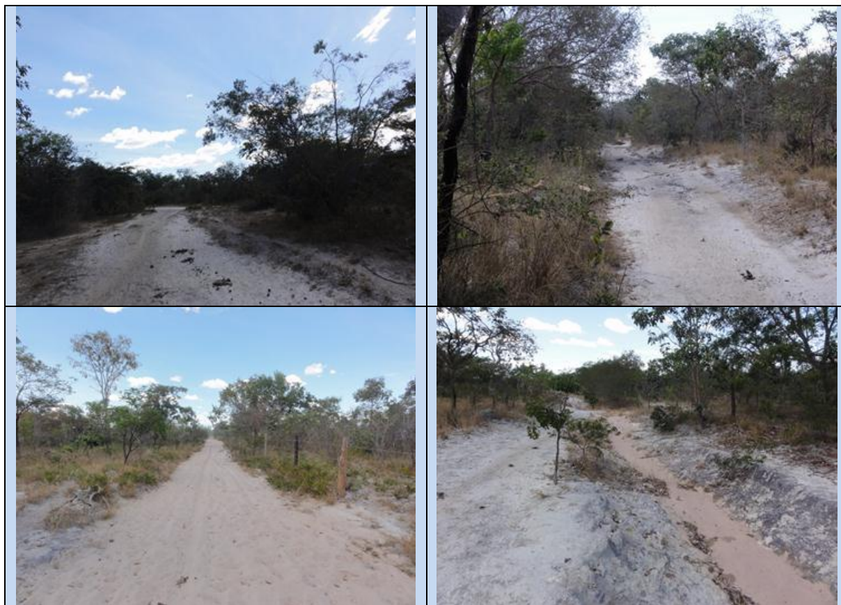
Figura 6.11 - Estrada 04 que deverá ser readequada.
