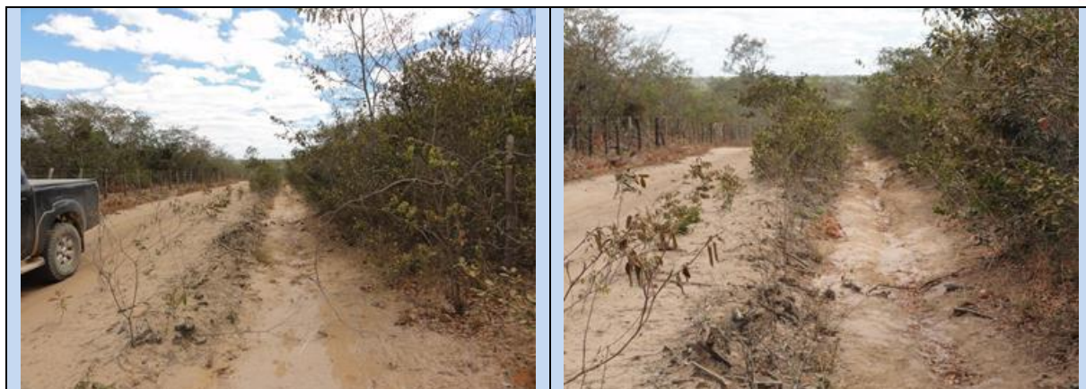
Figura 6.9 - Estrada 03 que deverá ser readequada.
