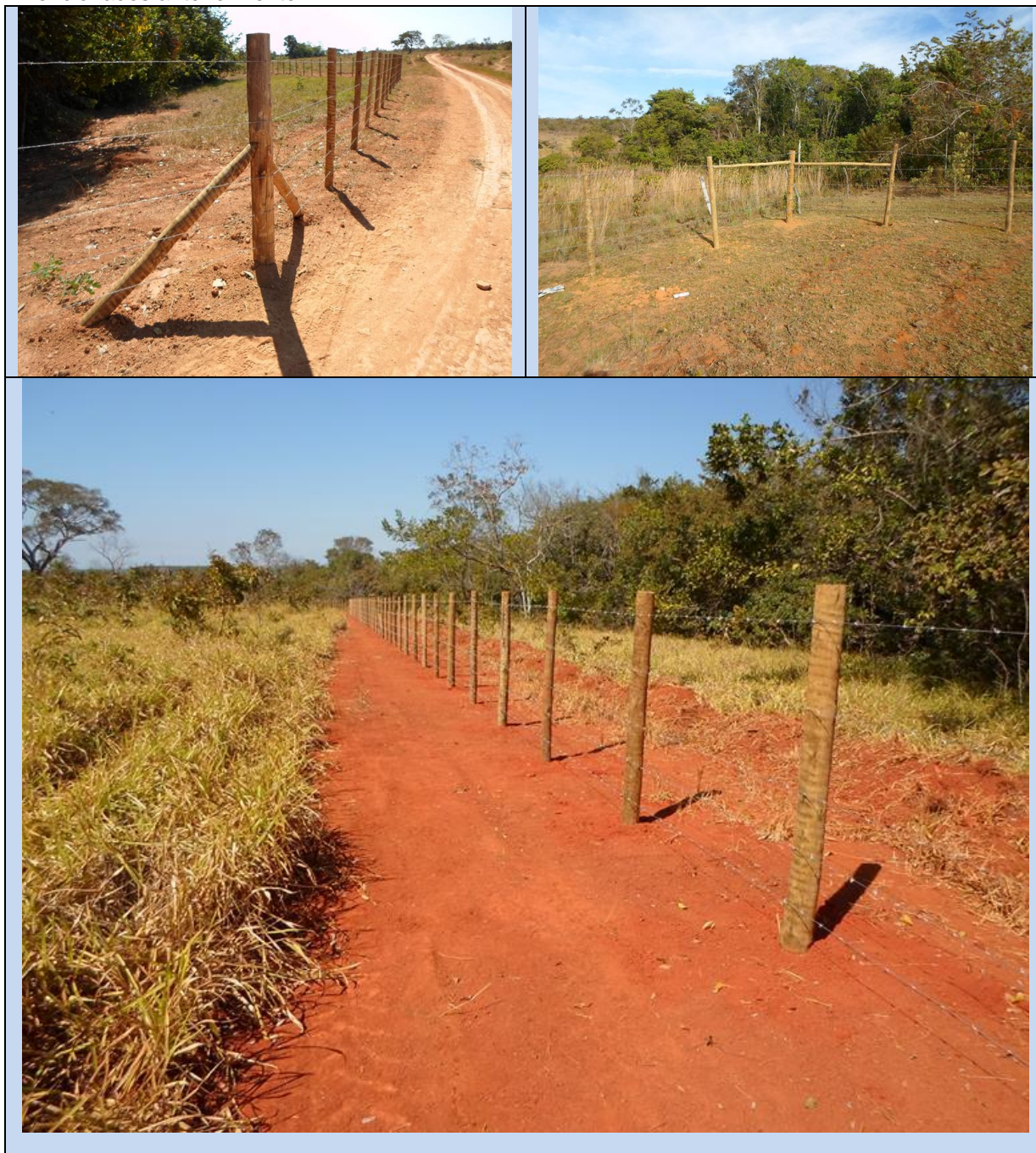
Figura 7.3 - Cercas construídas em obras hidroambientais da BHSF.
