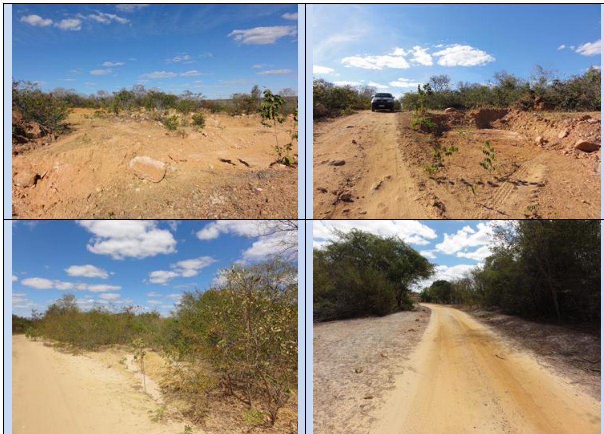
Figura 6.7 - Estrada 02 que deverá ser readequada.
