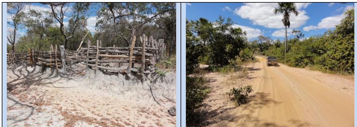
Figura 6.5 - Estrada 01 que deverá ser readequada.
