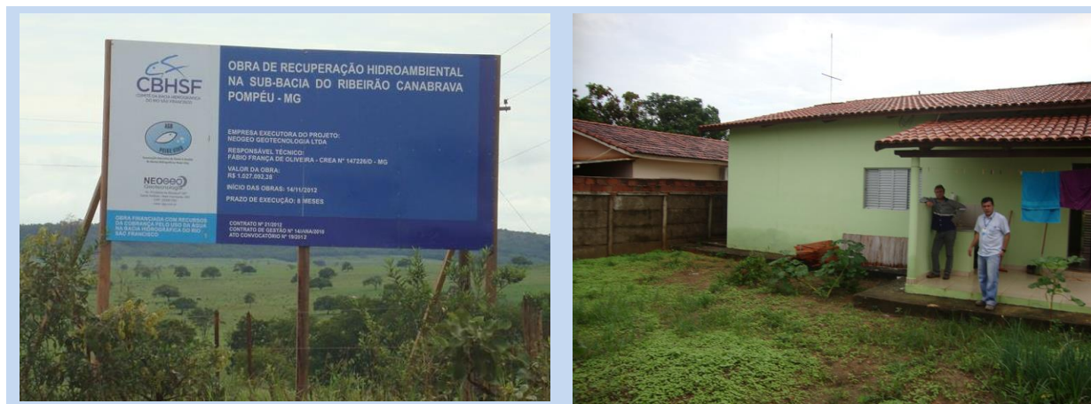
Figura 7.1 - Exemplo de Placa da Obra e Canteiro/Escritório dos projetos hidroambientais na bacia do rio São Francisco contratados pela AGB Peixe Vivo.
