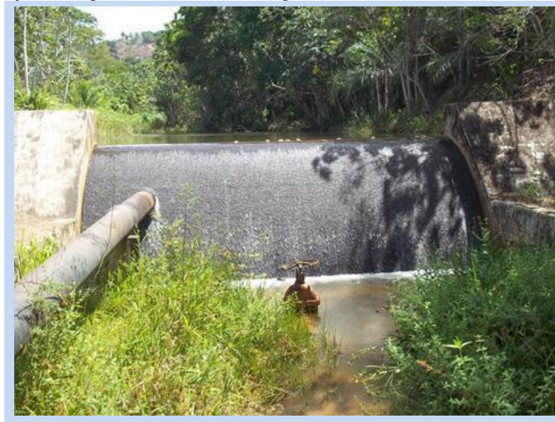
Figura 3.2– Barragem localizada no Riacho Riachão.
