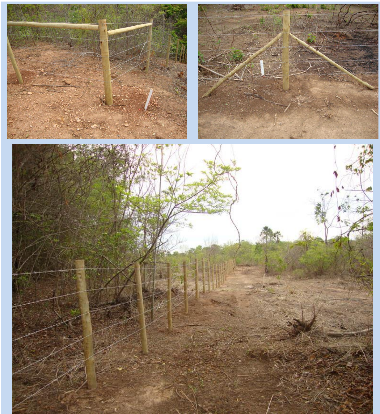
Figura 7.3 - Exemplo de cercas construídas com eucalipto tratado em projetos hidroambientais da bacia do rio São Francisco.
