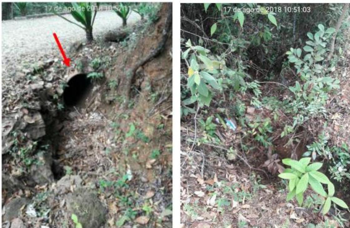
Figura 30 - Erosão linear em Macacos, com destaque para a manilha de drenagem de água pluvial.
