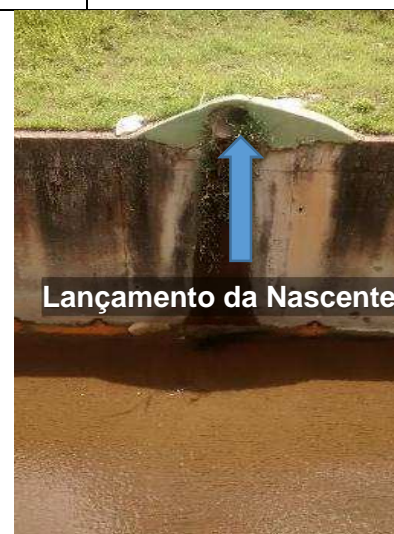
Destaque do ponto de saída no canal de drenagem.
