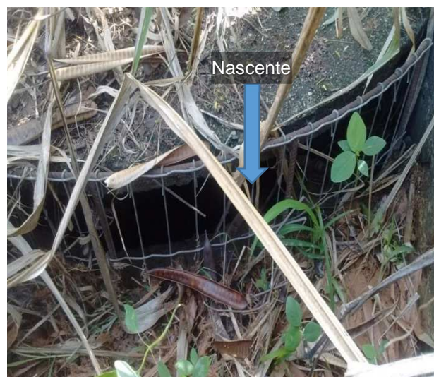
Estrutura de drenagem do terreno onde a água da nascente migrou após seu aterramento.
