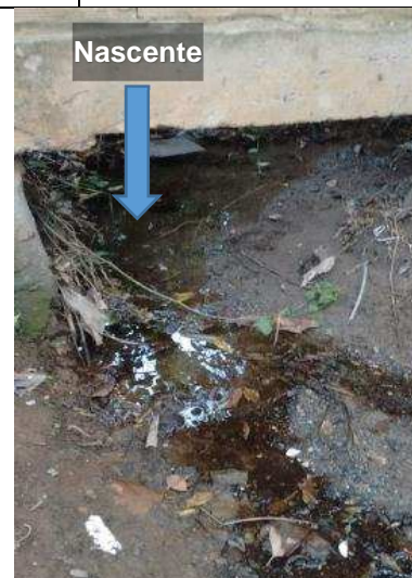
Nascente em área residencial
