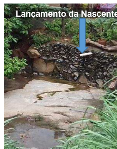
Detalhe da saída da água em tubulação de PVC
