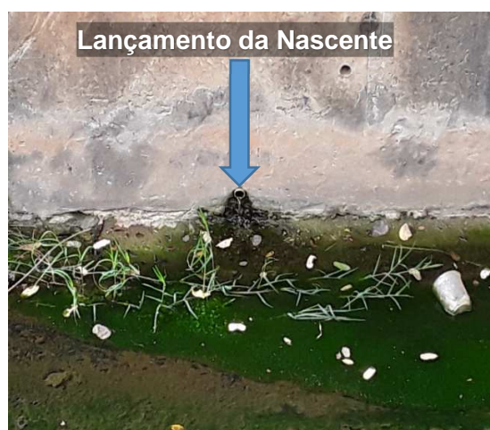
Detalhe da exfiltração no canal de drenagem construído no Córrego Várzea da Palma.
