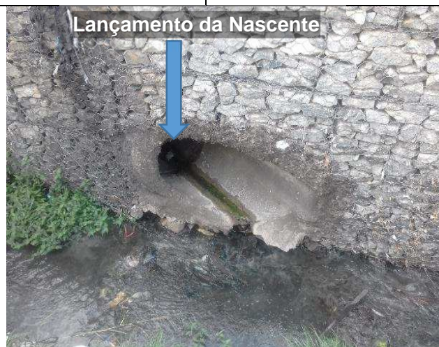
Em detalhes o fluxo de água da nascente interligado na drenagem pluvial que cai no canal de drenagem
