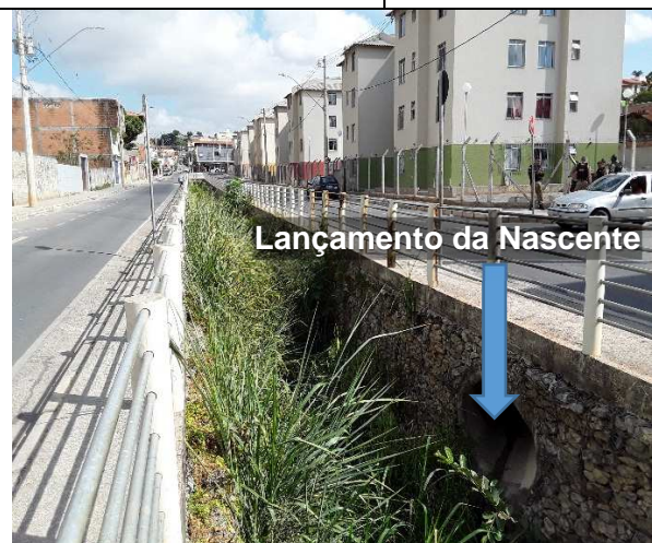
Vista do contexto da nascente com deságue no canal
