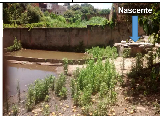
Destaque do ponto de exfiltração que acontece no interior da caixa de alvenaria.
