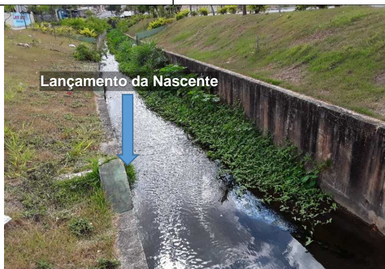
Vista do contexto da nascente no interior do canal de drenagem.
