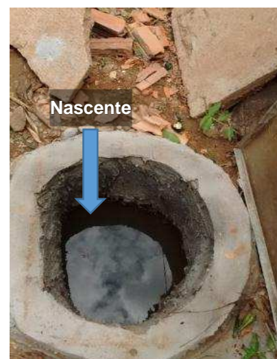
Ponto para onde a água da nascente foi drenada e confinada
