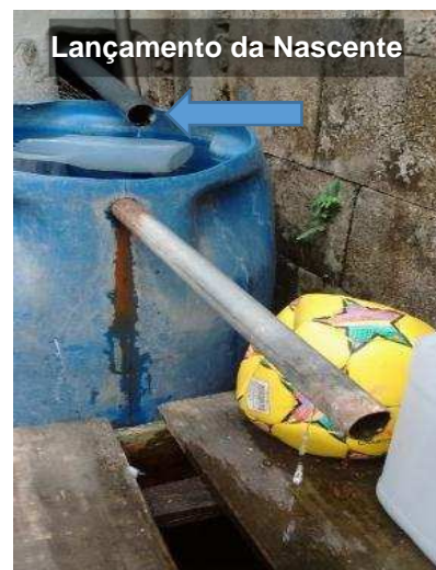
Ponto de deságue da água da nascente drenada
