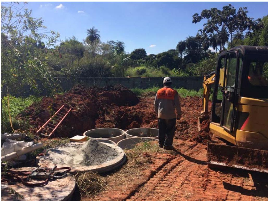
**Figura 64 – Construção da Fossá Septica com filtro biológico anaeróbico - Fonte: Gos Florestal**
