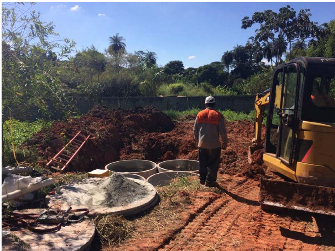
**Figura 23 – Construção das fossas Sépticas com filtro anaeróbico na área da Nascente - Fonte: Gos Florestal**
