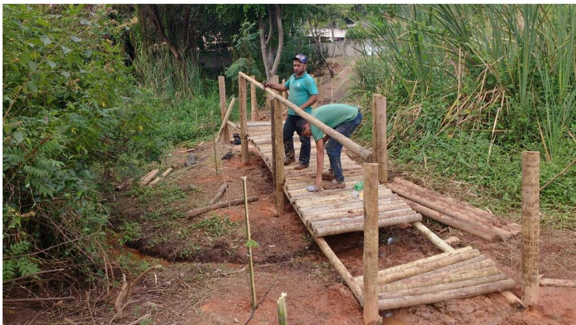
**Figura 21 – Drenagem, plantio de mudas e construção da passarela na Nascente do Brejinho - Fonte: Gos Florestal**
