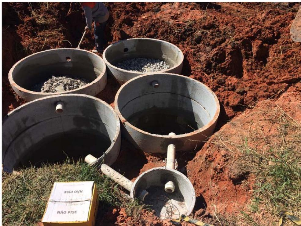
**Figura 65 – Construção da Fossá Septica com filtro biológico anaeróbico -**
