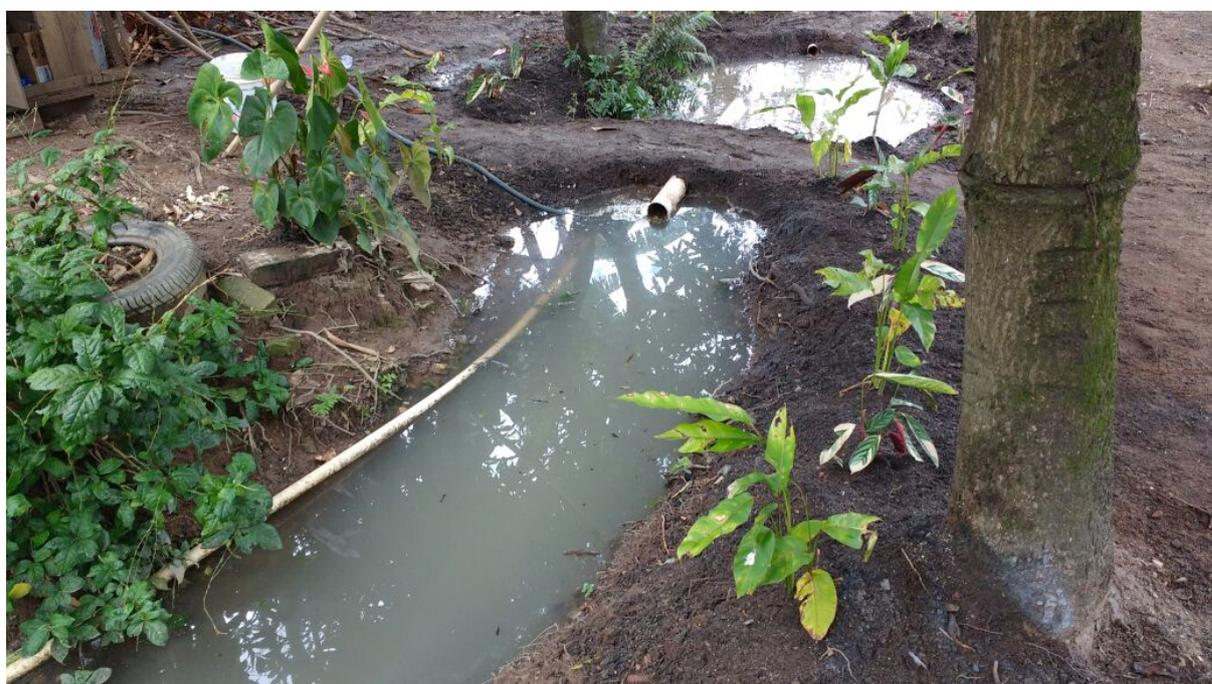
**Figura 24 – Limpeza, manutenção e plantio no canal de escoamento da água da nascente da Dona Marta - Fonte: Gos Florestal**
