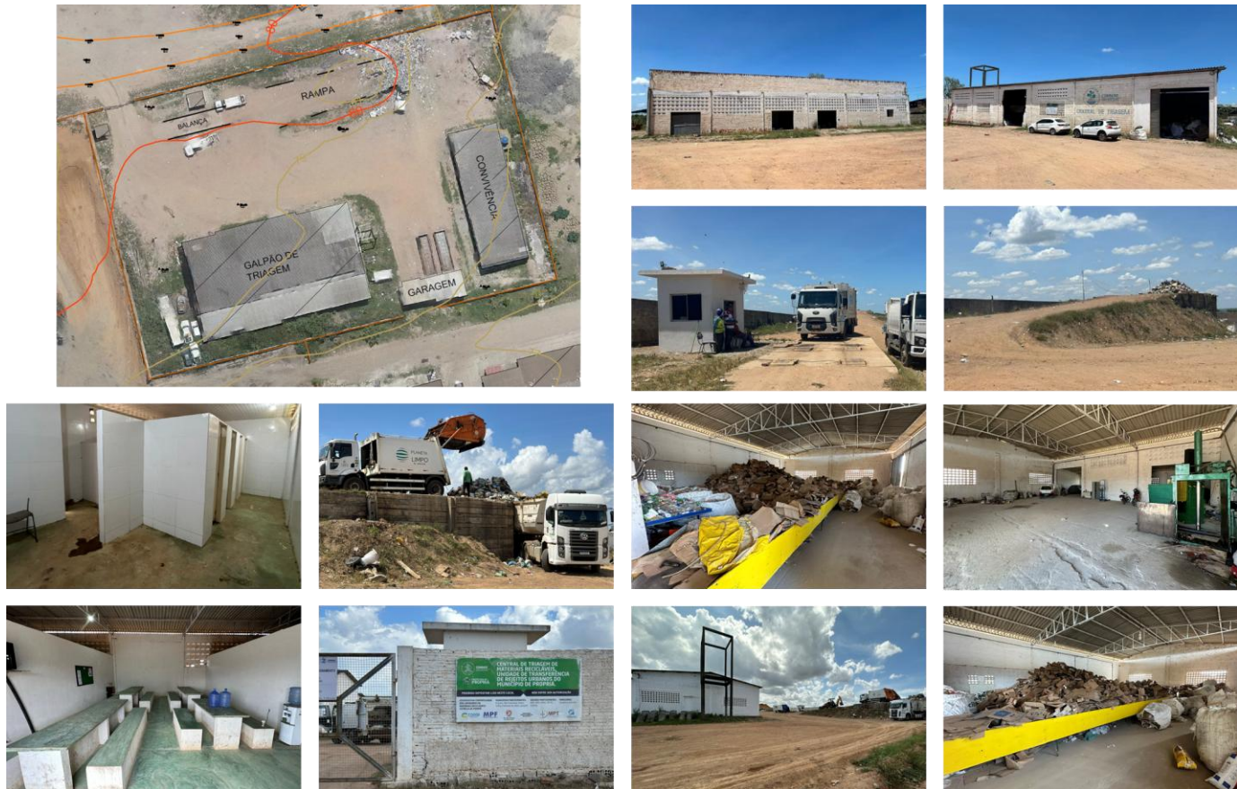
Figura 3. Localização e fotos das estruturas e unidades de operação dentro da Central de Triagem e Unidade de Transbordo de Propriá/SE.
