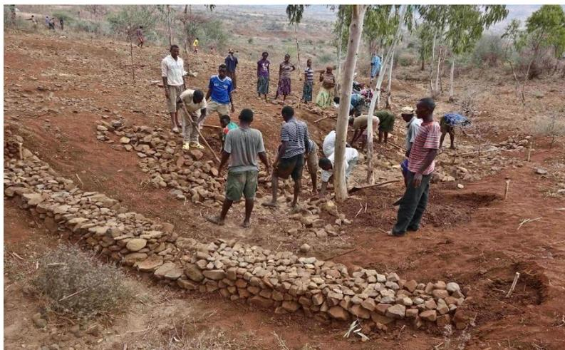
**Figura 9 - Cordões de pedra para contenção de ravinamento.**
