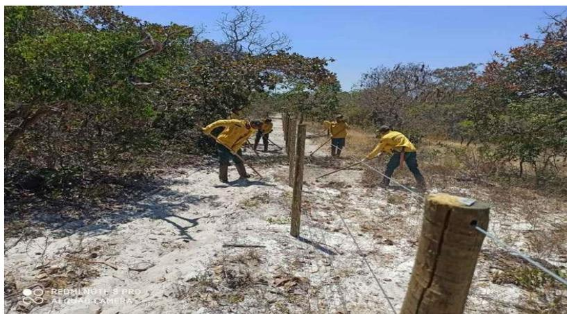
**Figura 7 - Aceiro sendo limpo para proteção contra incêndio.**
