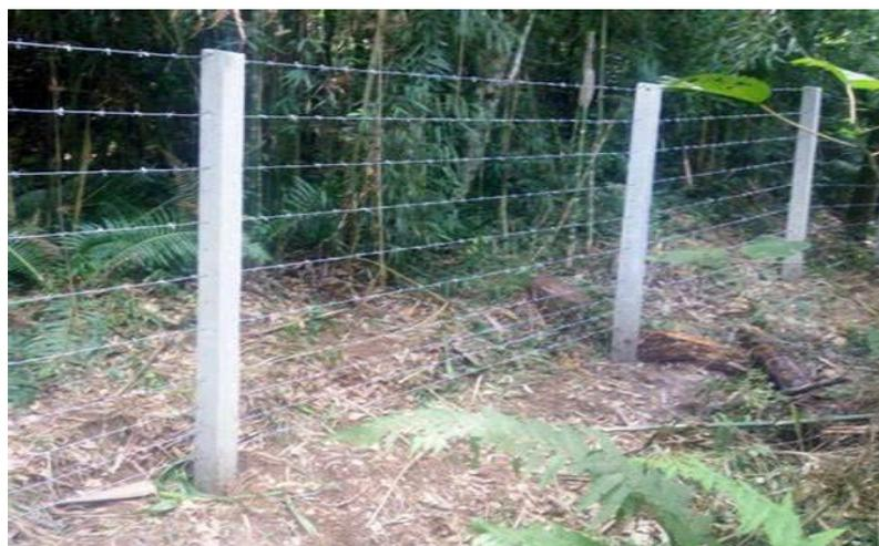
**Figura 8 - Cerca de arame farpado com mourões de concreto em área verde.**
