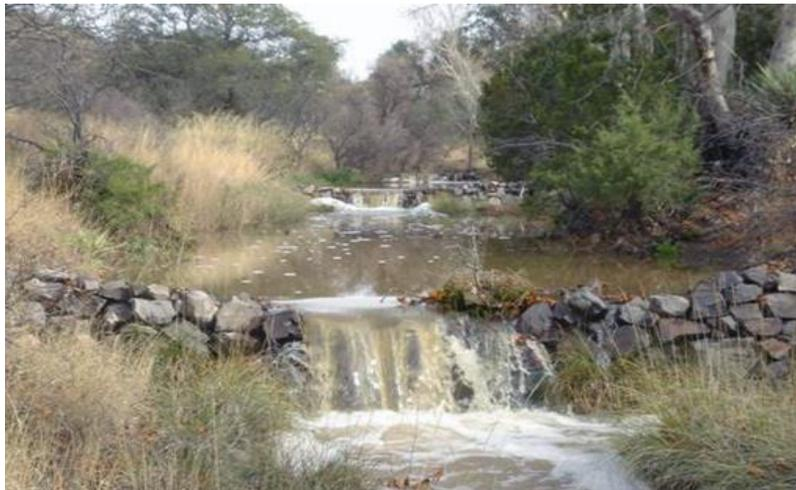
**Figura 12 - Diques de pedra para retenção de sedimentos e amortecimento da velocidade da água em um riacho.**
