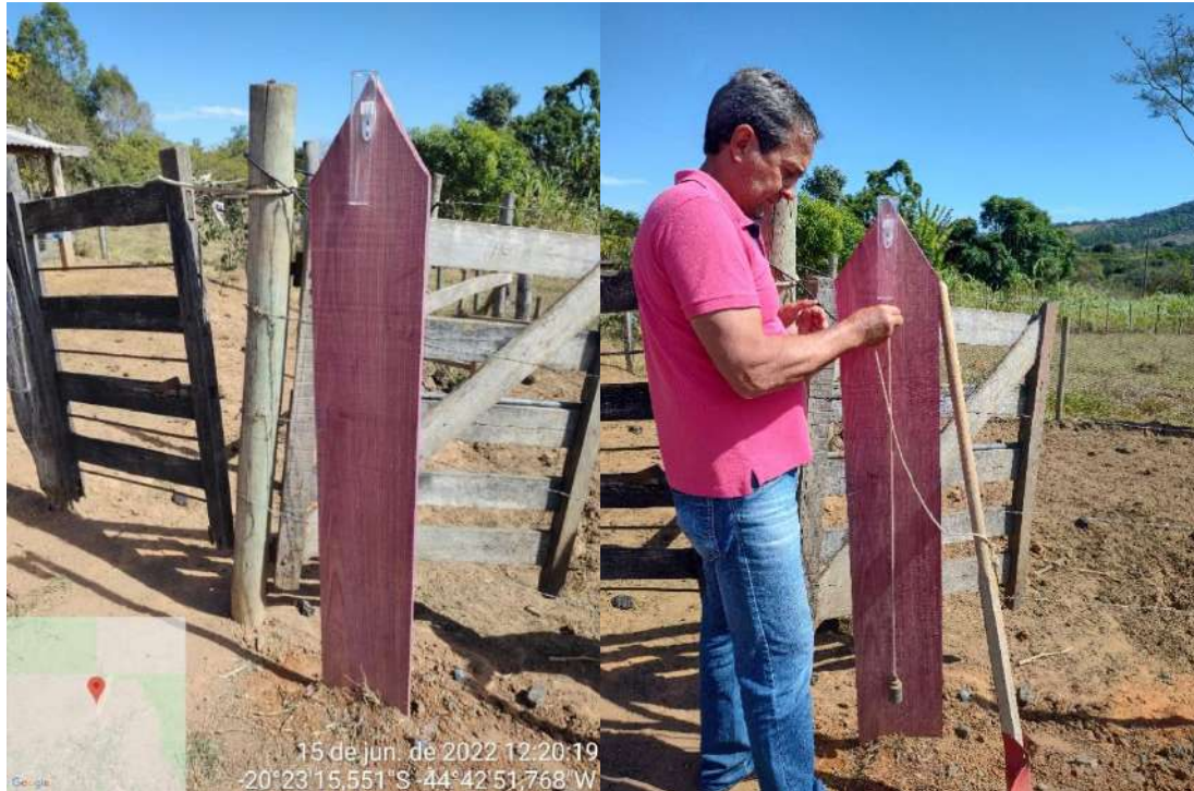
Figura 5.3 – Fixação e nivelamento da tábua de madeira de lei
