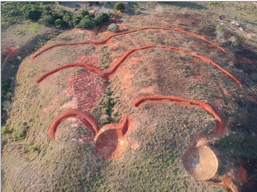
Figura 6.6 Terraços perpendiculares à drenagem do terreno e integrados às bacias de retenção em área levemente declivosa.
