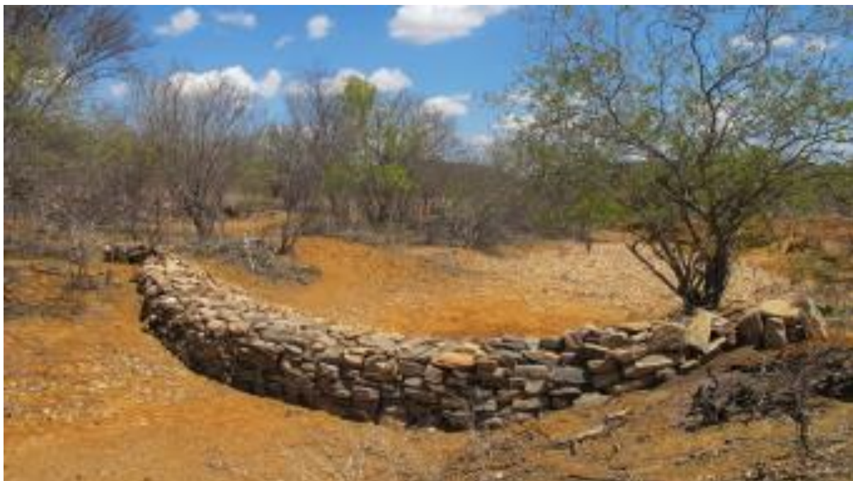
Figura 13 - Representação da estrutura de uma barragem sucessiva de pedra. Fonte: IRPAA (2013).
