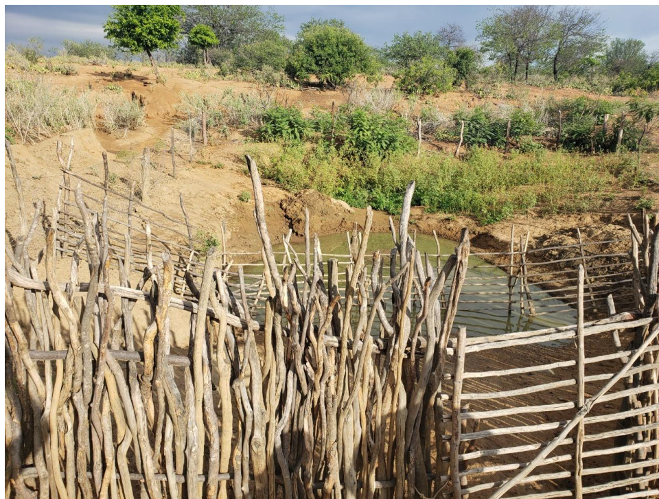
Figura 35 - Local onde será realizada a manutenção da cacimba.
