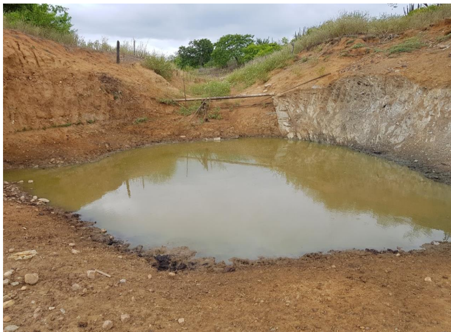
Figura 33 - Local onde será realizada a manutenção da cacimba.
