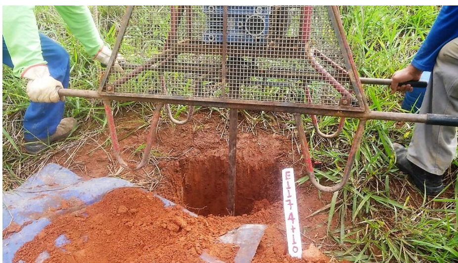
Figura 25 - Sondagem a trado.
