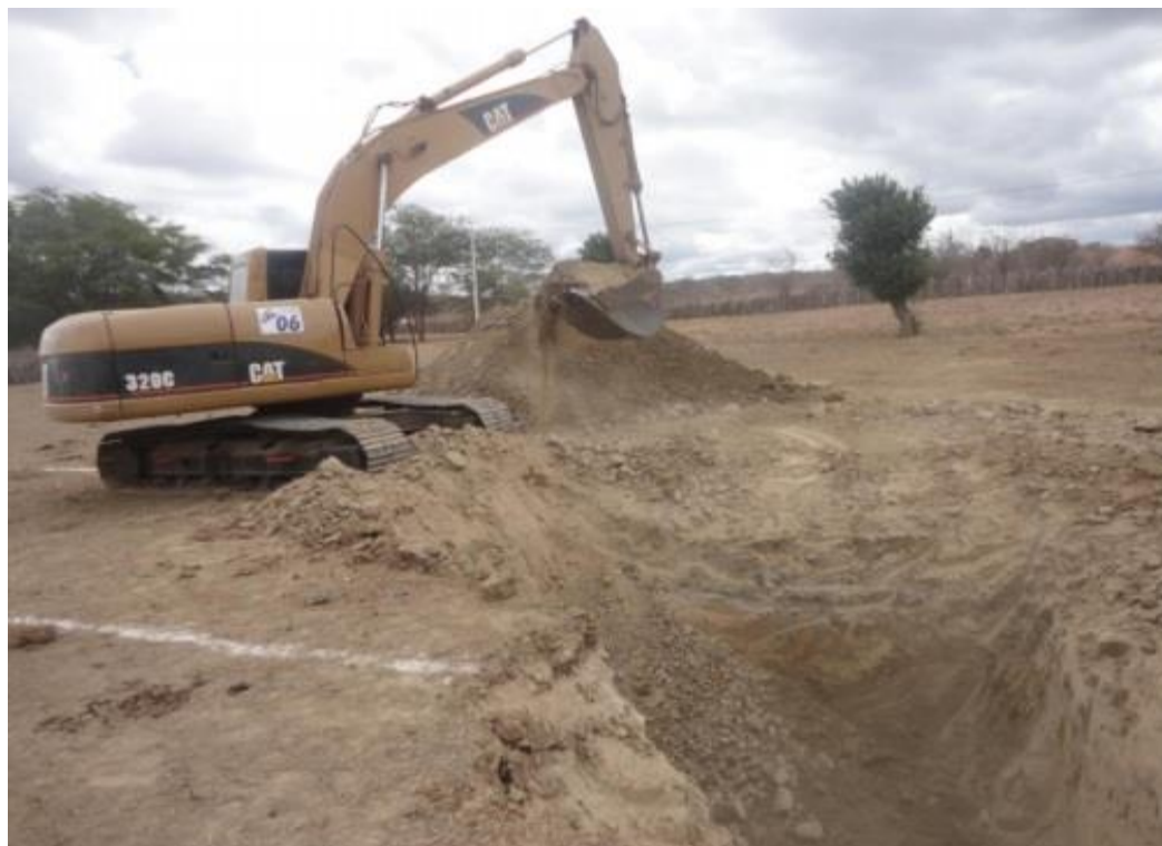
Figura 23 - Método de escavação utilizado na construção de barreiro trincheira. Fonte: Brasil (2015).
