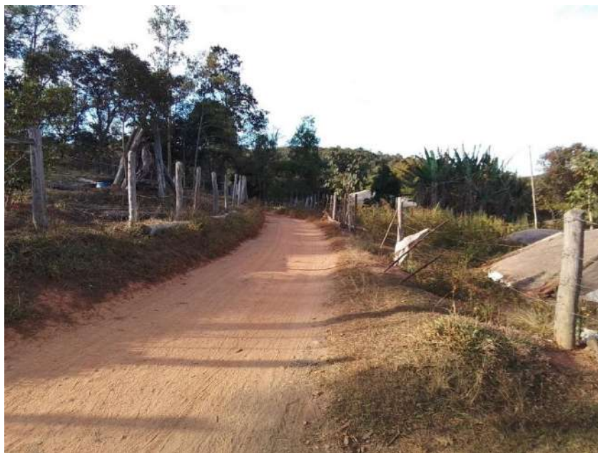
Figura 5.327 – Estrada de acesso à Propriedade 59
