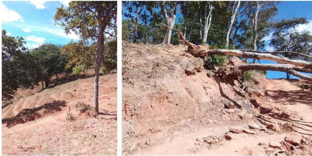
Figura 5.400 – Processos erosivos da Propriedade 77
