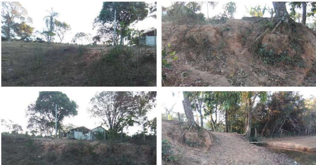
Figura 5.38 – Processos erosivos da Propriedade 5
