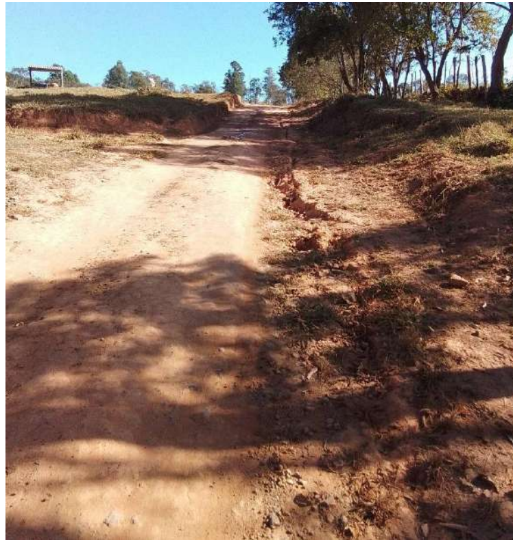
Figura 5.266 – Estrada de acesso à Propriedade 46
