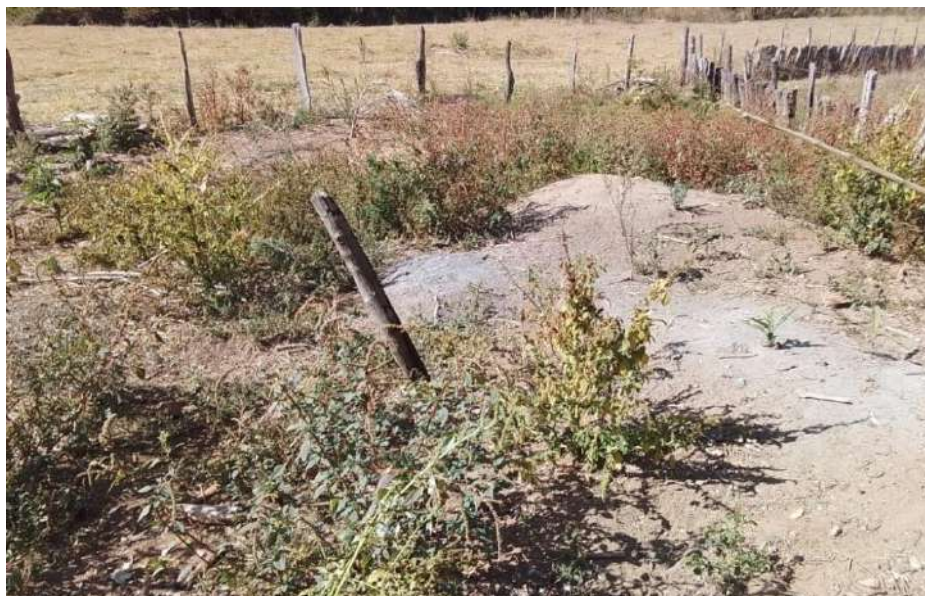
Figura 5.85 – Área da nascente desprotegida da Propriedade 13
