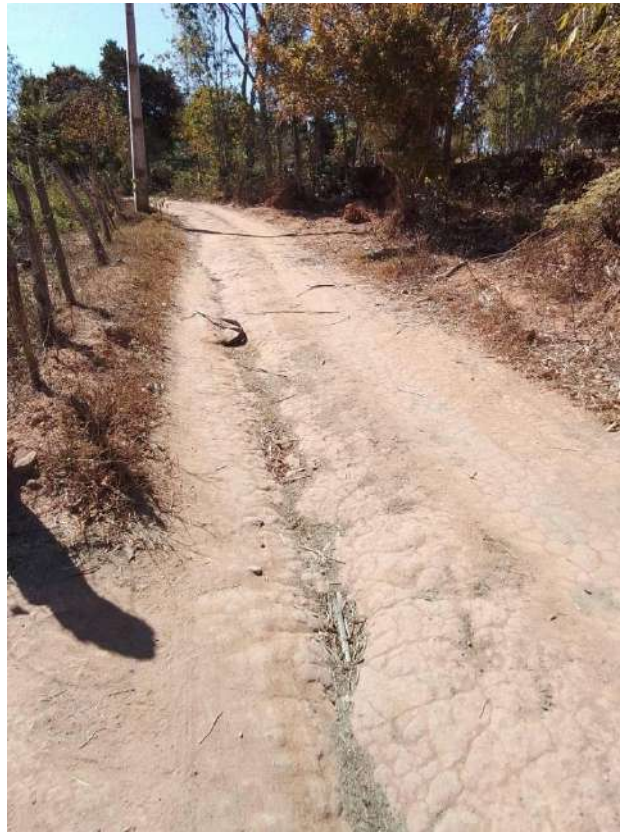
Figura 5.338 – Estrada de acesso à Propriedade 62
