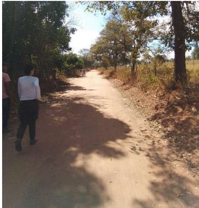
Figura 5.132 – Estrada de acesso à Propriedade 21
