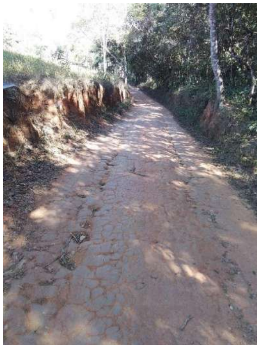
Figura 5.190 – Estrada de acesso à Propriedade 31
