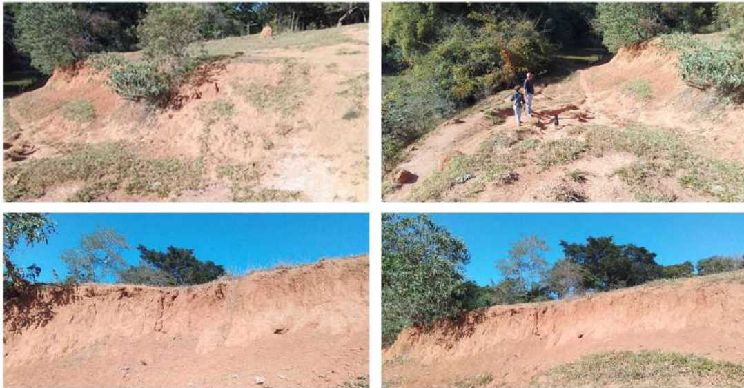
Figura 5.32 – Processos erosivos da Propriedade 4
