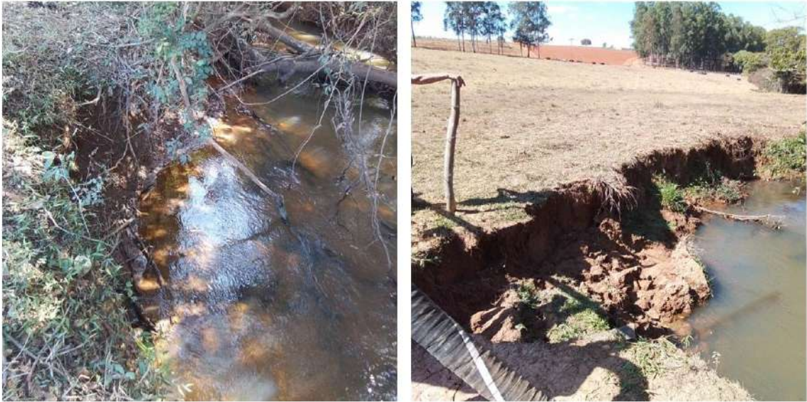
Figura 5.69 – Processos erosivos da Propriedade 10
