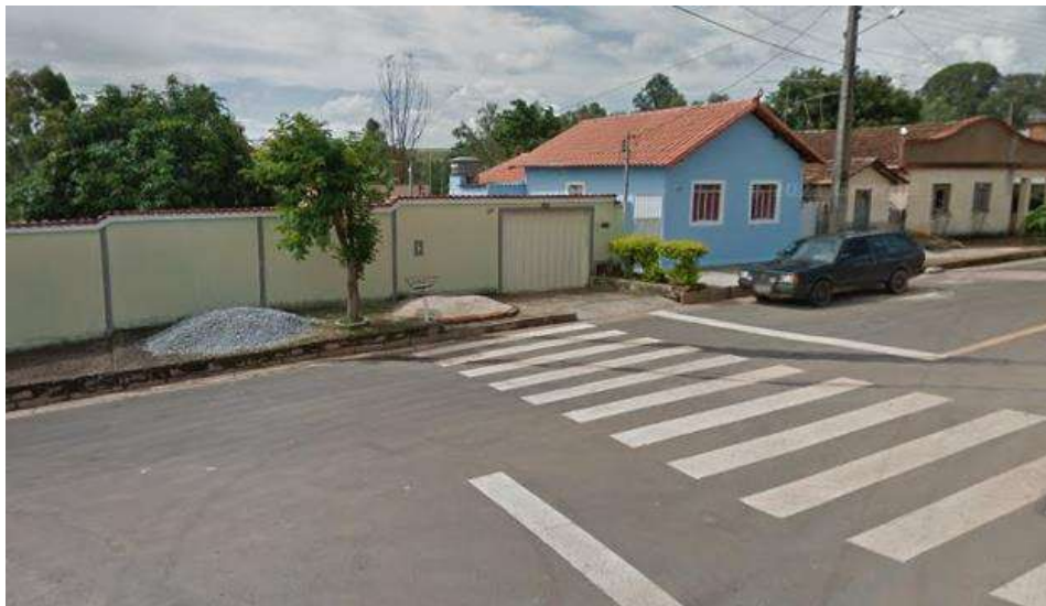
Figura 5.247 – Estrada de acesso à Propriedade 42
