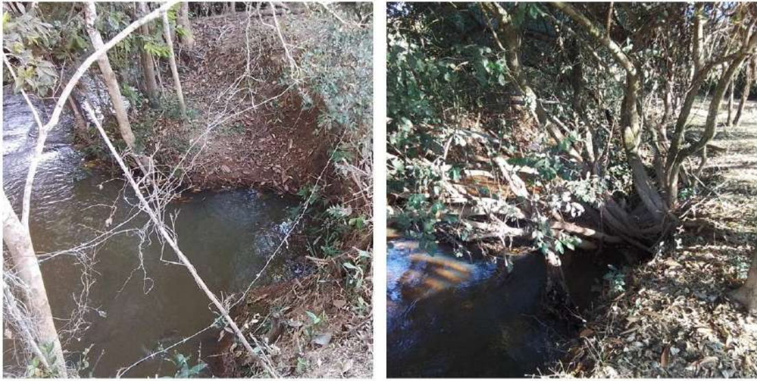
Figura 5.256 – Processos erosivos da Propriedade 44
