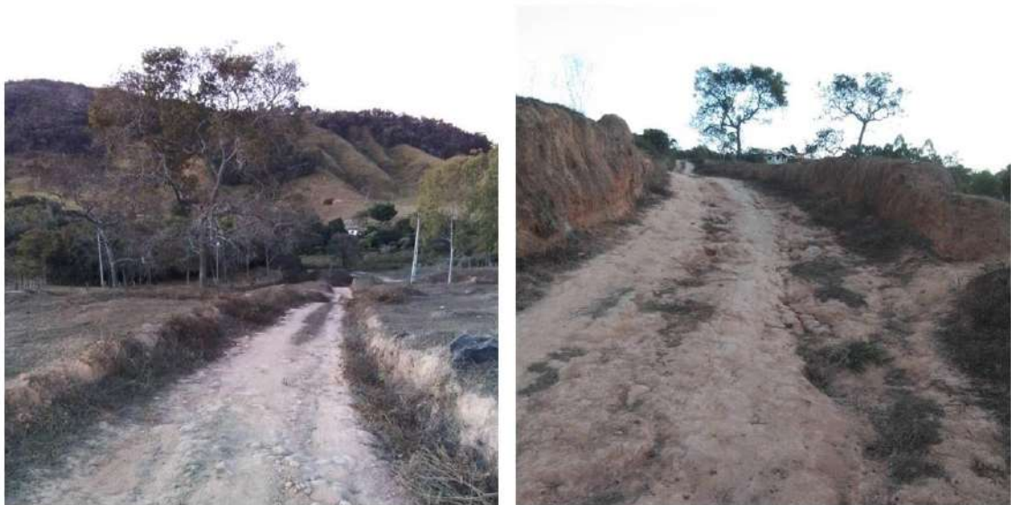
Figura 5.295 – Estrada de acesso à Propriedade 52
