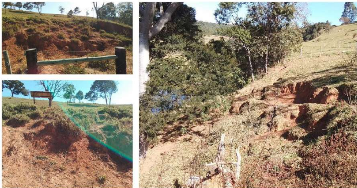
Figura 5.151 – Processos erosivos da Propriedade 24
