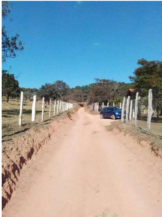
Figura 5.200 – Estrada de acesso à Propriedade 33
