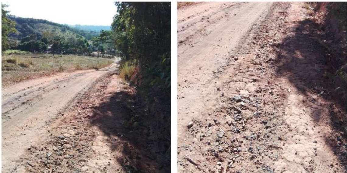
Figura 5.253 – Estrada de acesso à Propriedade 43
