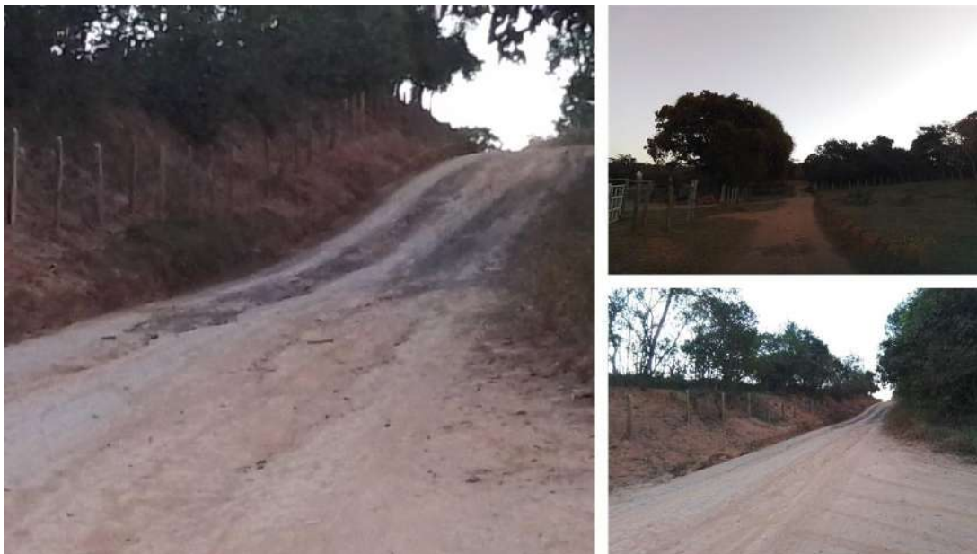
Figura 5.44 – Estrada de acesso à Propriedade 6
