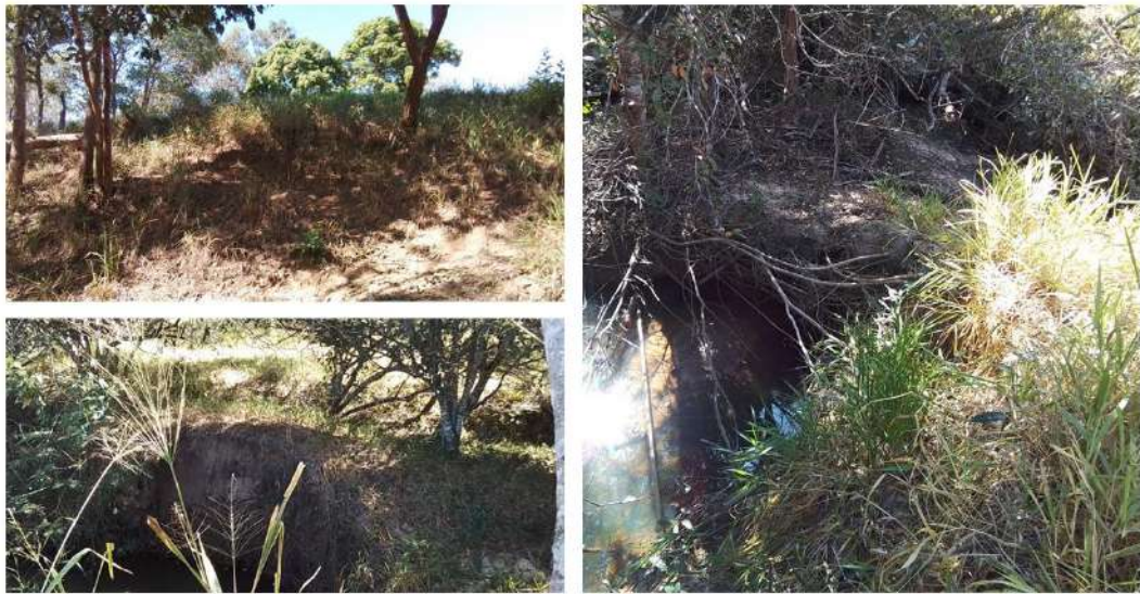
Figura 5.209 – Processos erosivos da Propriedade 35
