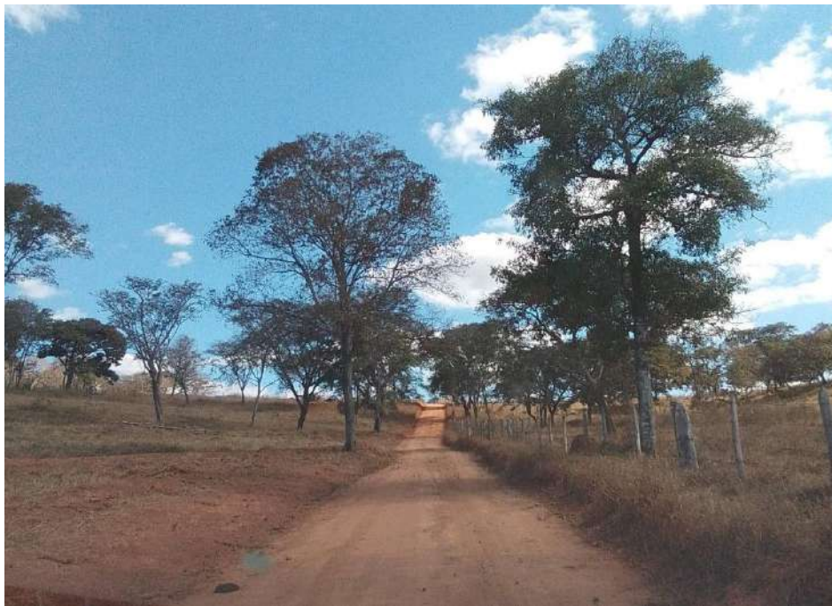
Figura 5.87 – Estrada de acesso à Propriedade 13
