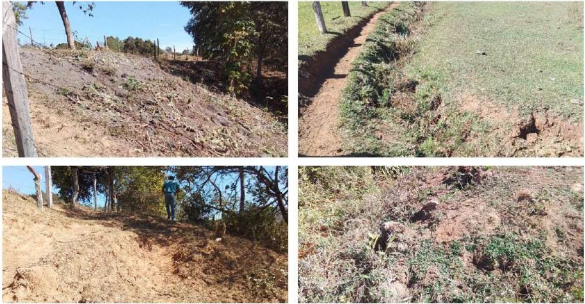
Figura 5.19 – Erosão na Propriedade 2
