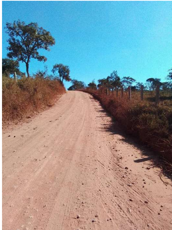
Figura 5.107 – Estrada de acesso à Propriedade 16
