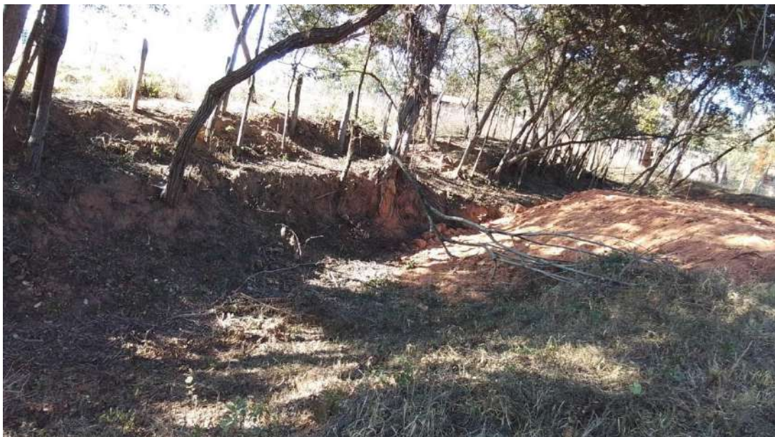
Figura 5.225 – Processo erosivo da Propriedade 38
