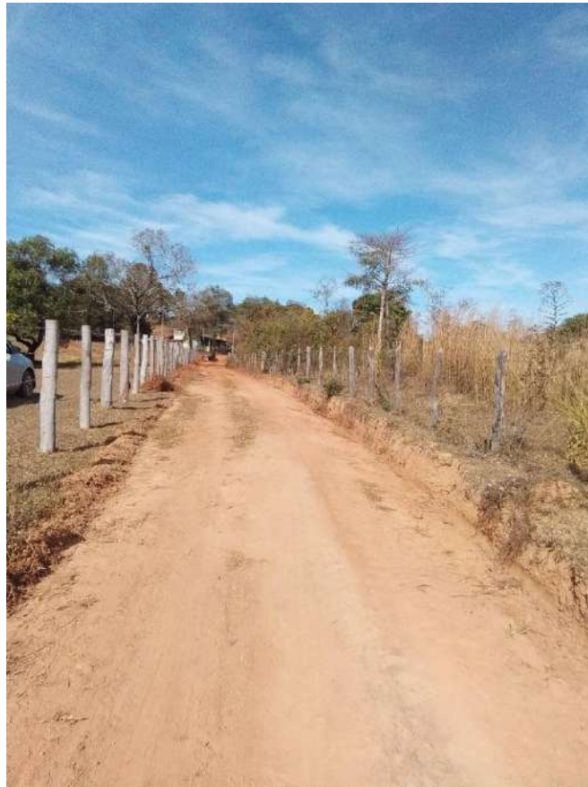
Figura 5.398 – Estrada de acesso à Propriedade 76
