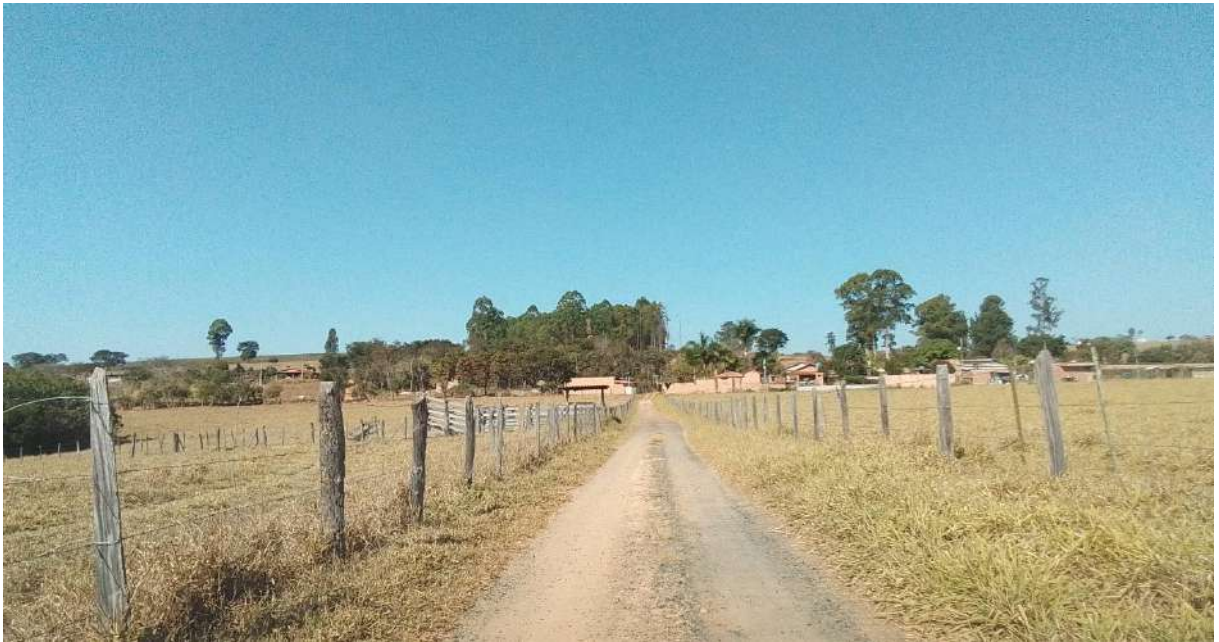
Figura 5.75 – Estrada de acesso à Propriedade 11
