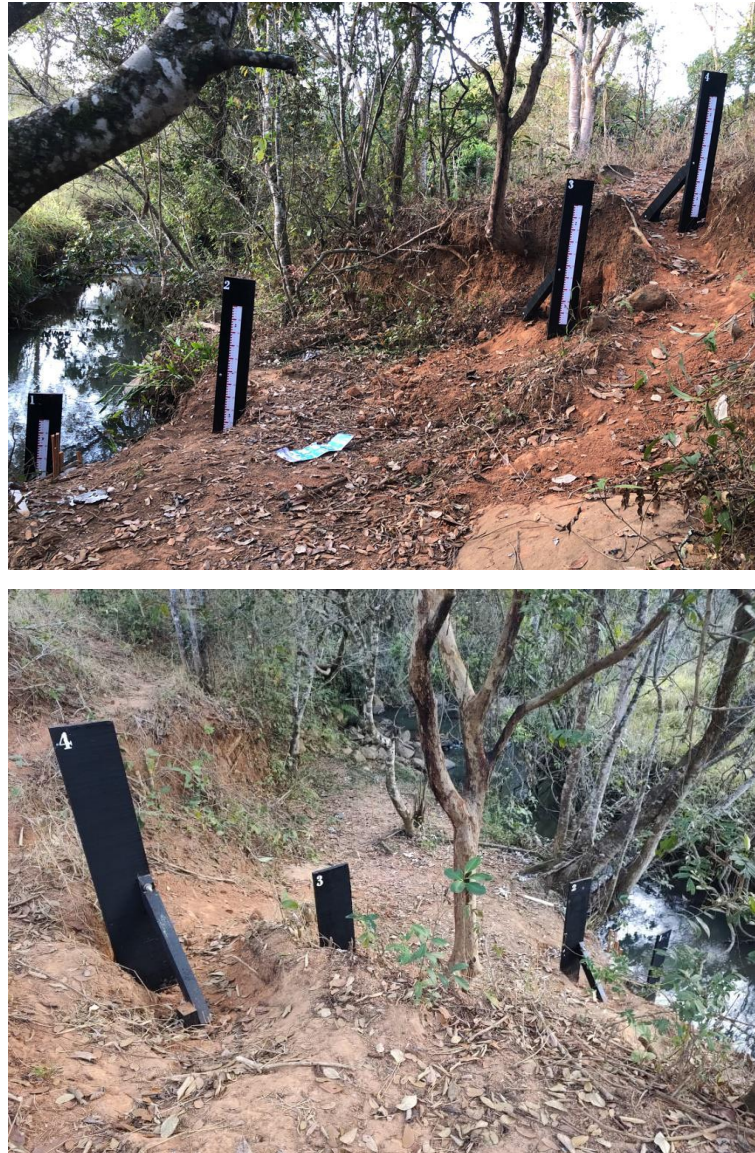
Figura 5.9 – Réguas linimétricas instaladas no Ribeirão do Custódio, em Cláudio/MG
