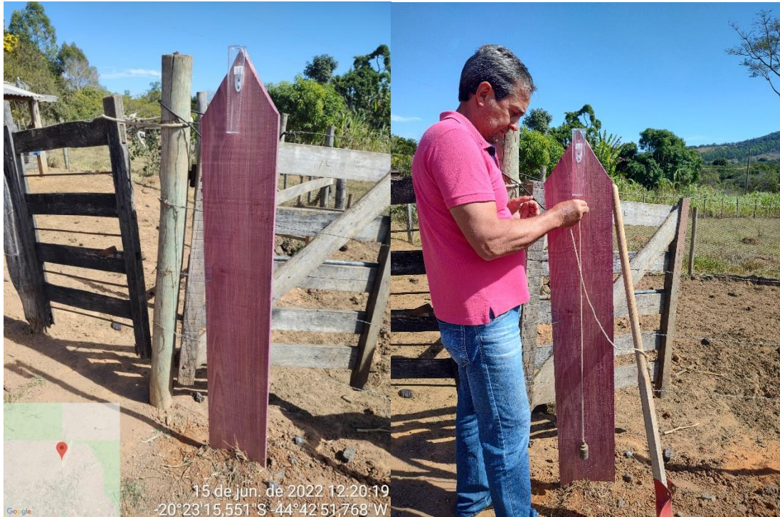
Figura 5.4 – Fixação e nivelamento da tábua de madeira de lei
