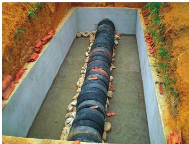
Figura 6 - Exemplo de preenchimento da Câmara Anaeróbia da TEVAP Fonte: (EMATER, 2014)
