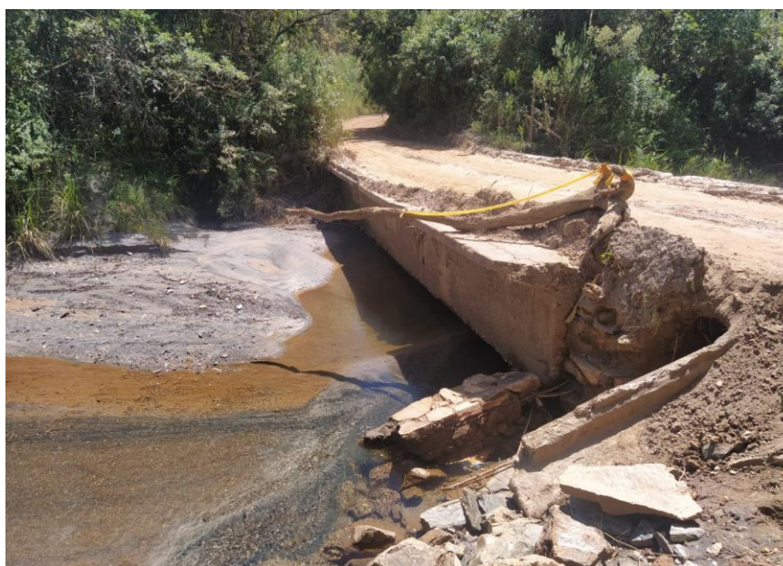
Figura 2 - Ponte sobre o rio assoreado - exemplo do assoreamento do leito do Rio Maracujá (Fonte: própria)
