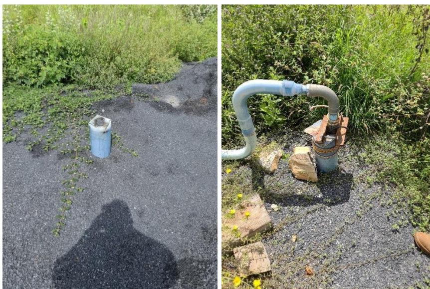
Figura 3 – Vista dos poços tubulares que serão utilizados para o abastecimento de água para o viveiro de mudas
