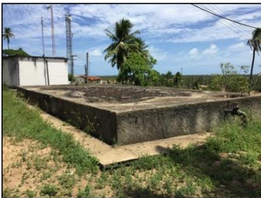
Figura 6 - Reservatório Semi-enterrado (FONTE: Plano Municipal de Saneamento Básico de Feliz Deserto, 2018).
