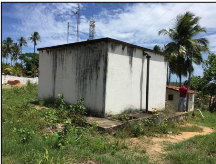
Figura 5 - Reservatório Apoiado (FONTE: Plano Municipal de Saneamento Básico de Feliz Deserto, 2018).
