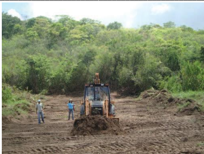
Figura 34 – Representação da limpeza da área para a implantação da barragem subterrânea
