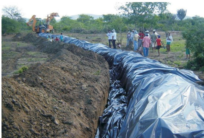
Figura 37 – Representação da colocação da lona
