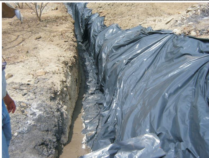
Figura 38 – Representação da fixação da lona
