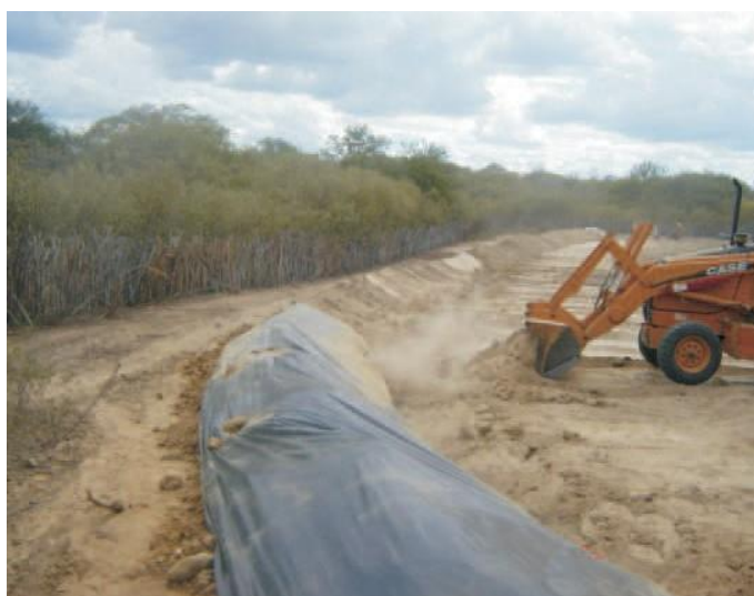
Figura 39 – Representação do fechamento da vala
