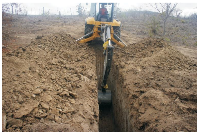
Figura 35 – Representação da escavação da vala
