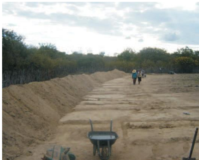
Figura 40 – Representação do acabamento da vala Fonte: EMBRAPA (2011).
