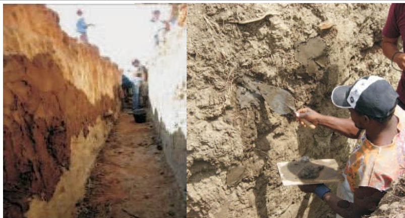
Figura 36 – Representação da limpeza e reboco das paredes
