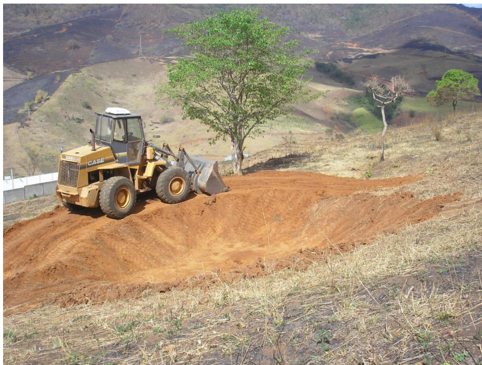
Figura 22 – Compactação do Solo Durante a Construção de uma Bacia de Contenção Fonte: Charmelo (2010).
