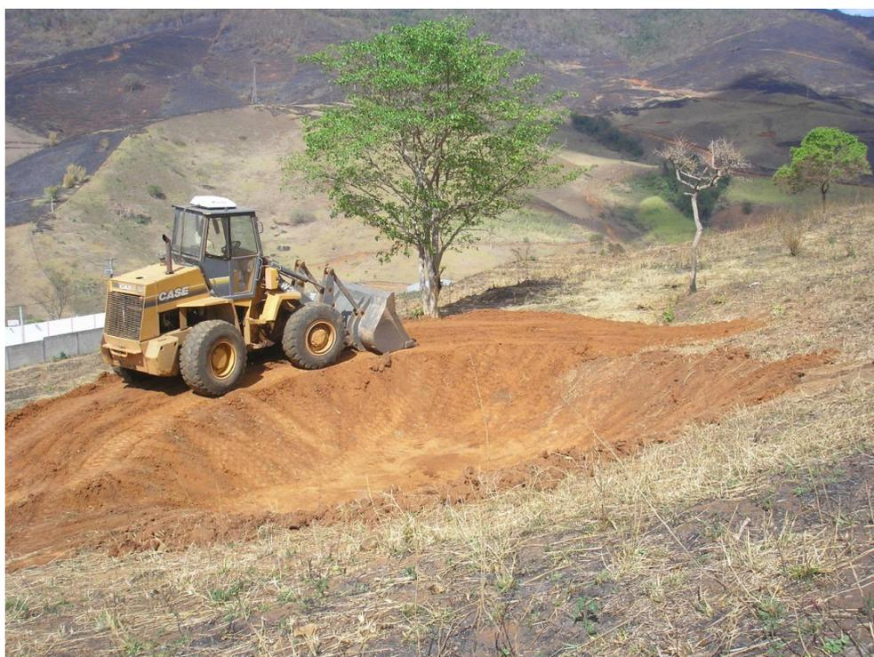
**Figura 21 – Compactação do Solo Durante a Construção de uma Bacia de Contenção**
