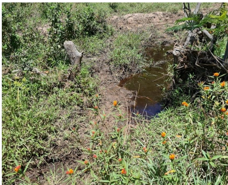
Figura 7 – Afloramento/Acúmulo de água à jusante da nascente
