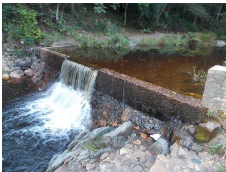
Figura 23 – Representação esquemática de uma barragem de pedra argamassada
