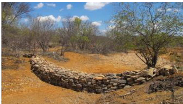
Figura 18 – Representação da estrutura de uma barragem sucessiva de contenção de sedimentos
