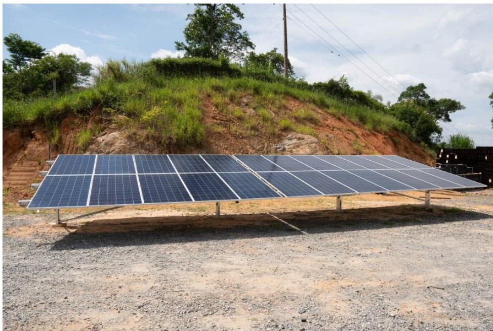
Figura 14.5 – Vista geral do sistema de placas montado.
