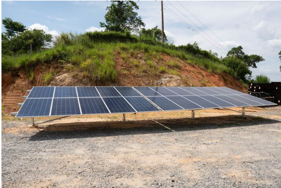
Figura 6.5 – Vista geral do sistema de placas montado.
