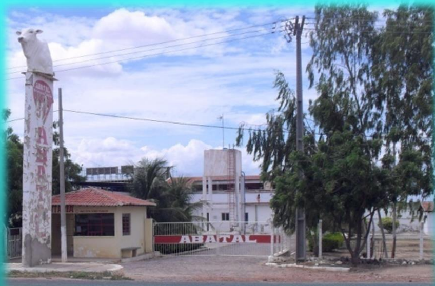
ABATAL – Abatedouro-frigorífico para abate de bovinos, caprinos, ovinos e suínos - município de Juazeiro.
