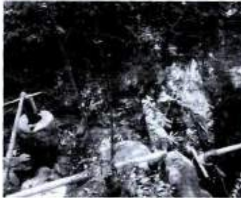
Figura 50: Detalhe da captação de água para o vado em João Rodrigues.
