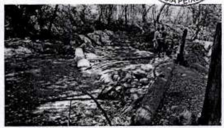
Figura 3 - Vista da soleira do barramento.
