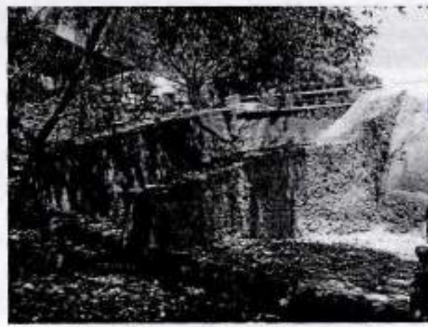
Figura 23 - Vista posterior do barramento.
