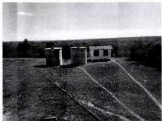
Figura 45: Visão da Estação de Tratamento de Água da Embasa.
