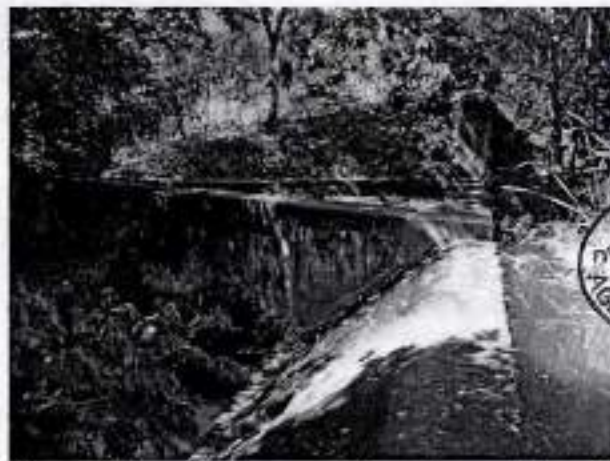
Figura 35 - Água escoando pelo vertedor do barramento.
