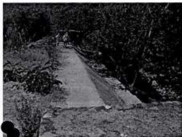
Figura 10 - Vertedouro do Barramento da Mata.
