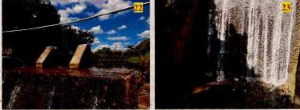
Foto 22 e 23 – Em 22 vista da comporta para descarga líquida do barramento, em 23 orifício para a descarga líquida da barragem.
