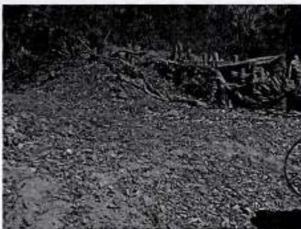
Figura 39 – Intervenção para desvio de água do ribeiro.
