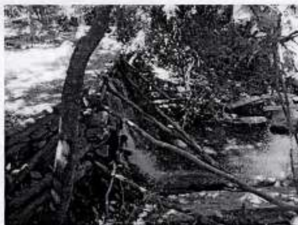
Figura 15 - Vertedores do barramento.
