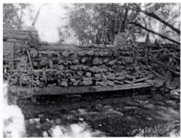
Figura 2 - Vista frontal do Barramento Brejo Novo.
