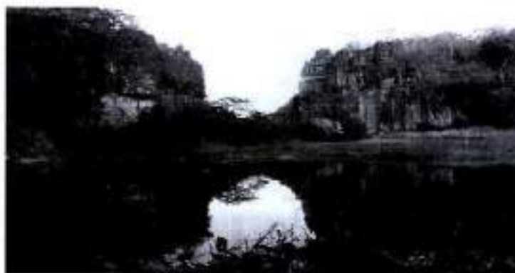
Figura 55 - Vista do paredão, por meio dele a água de João Rodrigues passa para a Tiririca e abastece a Lagoa Azul .
