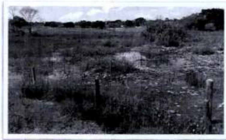
Figura 47: Vista lateral e de cima da barragem na comunidade de Mozondó próxima a Igreja e quadra de esportes.
