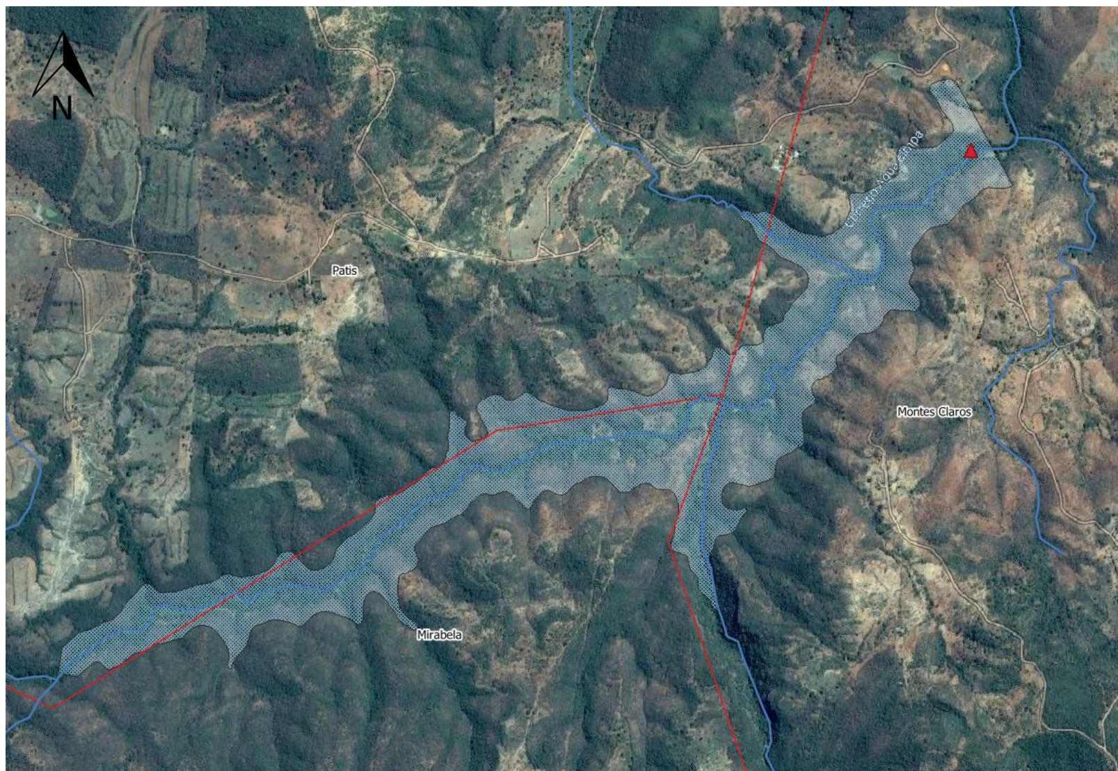
Figura 2 - Localização da área de implantação da barragem Água Limpa.
