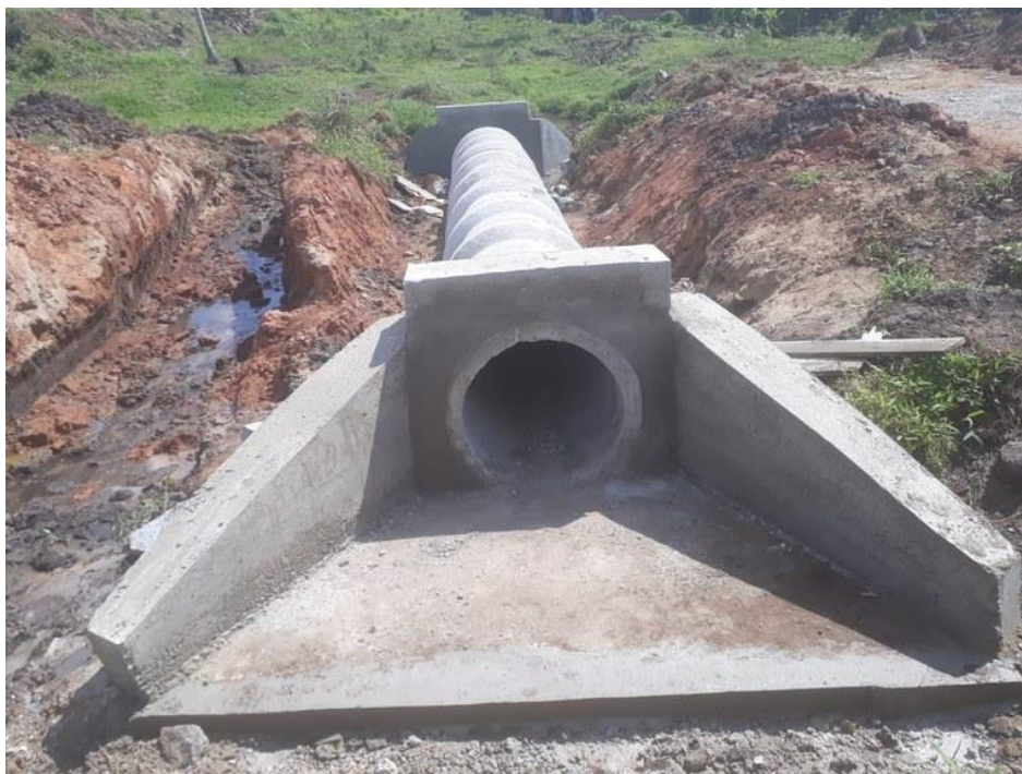
Figura 14 - Bueiro simples tubular de concreto em processo de construção.
