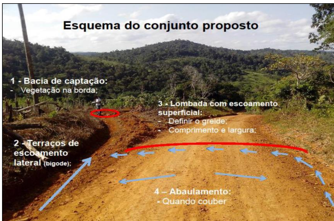
Figura 13 - Esquema do conjunto em funcionamento (bacia de captação, bigode e lombada). Fonte: ANA, 2018.
