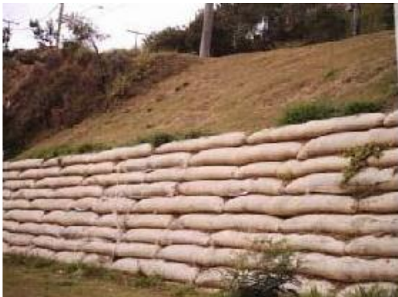
Figura 17 - Muro de rip-rap de solo-cimento ensacado.
