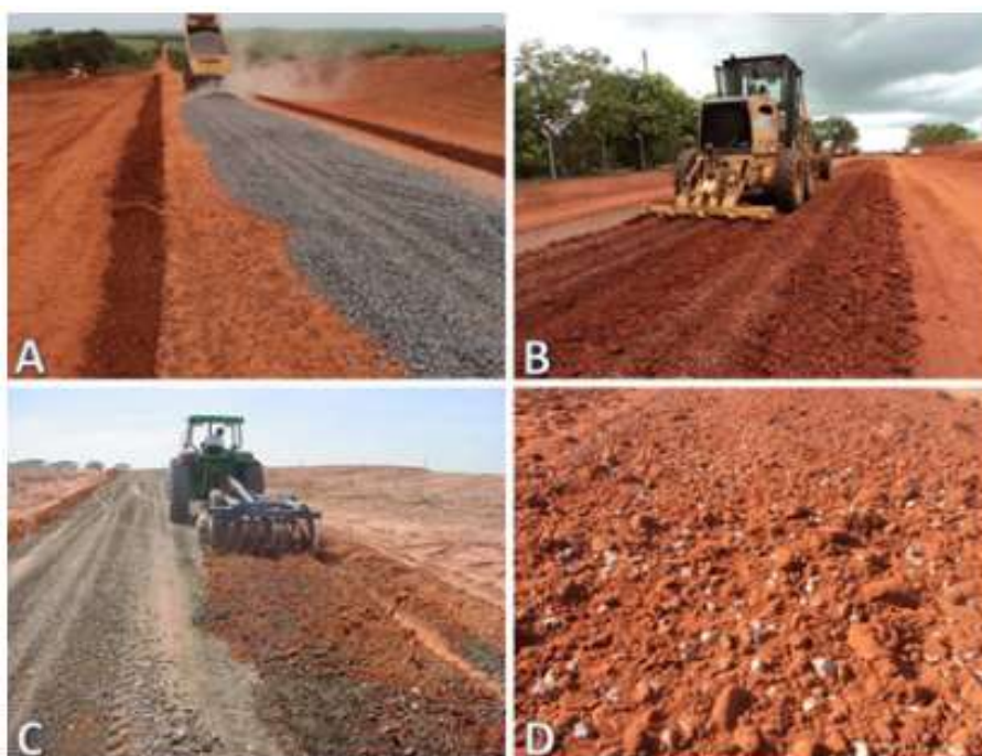
Figura 18 - Processo de lançamento e homogeneização para implantação de revestimento primário em estrada.
