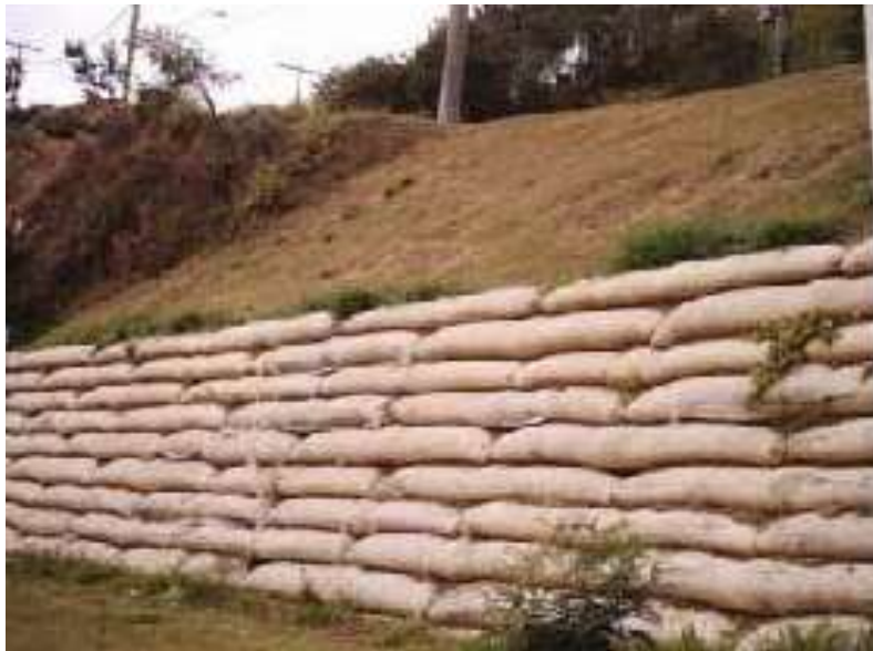
Figura 17 - Muro de rip-rap de solo-cimento ensacado.
