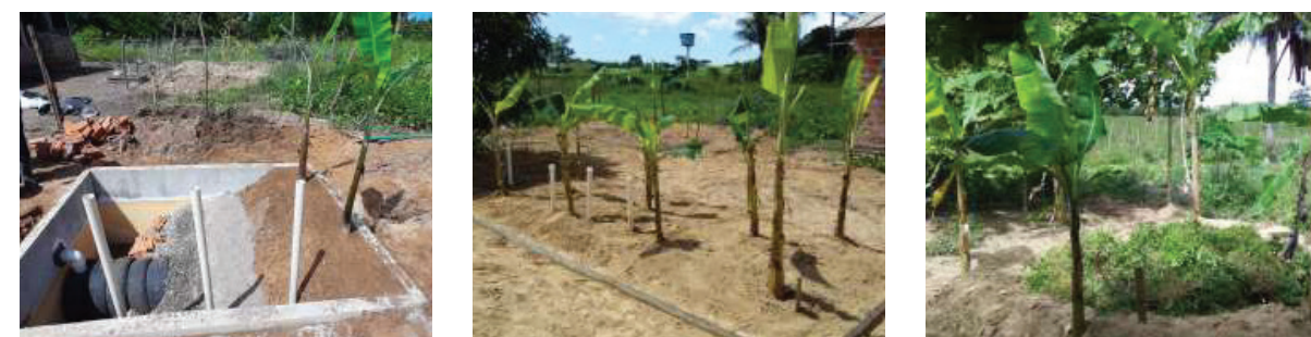
Projeto de construção de fossas agroecológicas em Penedo/AL
