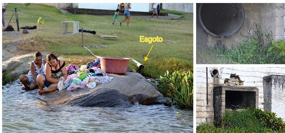
Figura 81 - Despejo de esgoto diretamente no rio.
