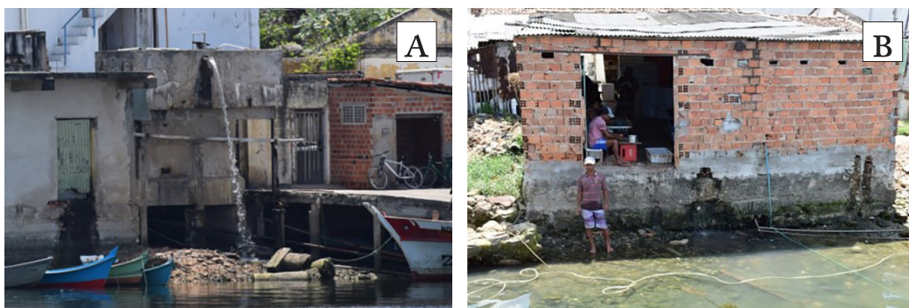
Figura 147 - Lançamentos diretos de esgotos sem tratamento no rio no BSF. A – fábrica de gelo; B – peixaria.
