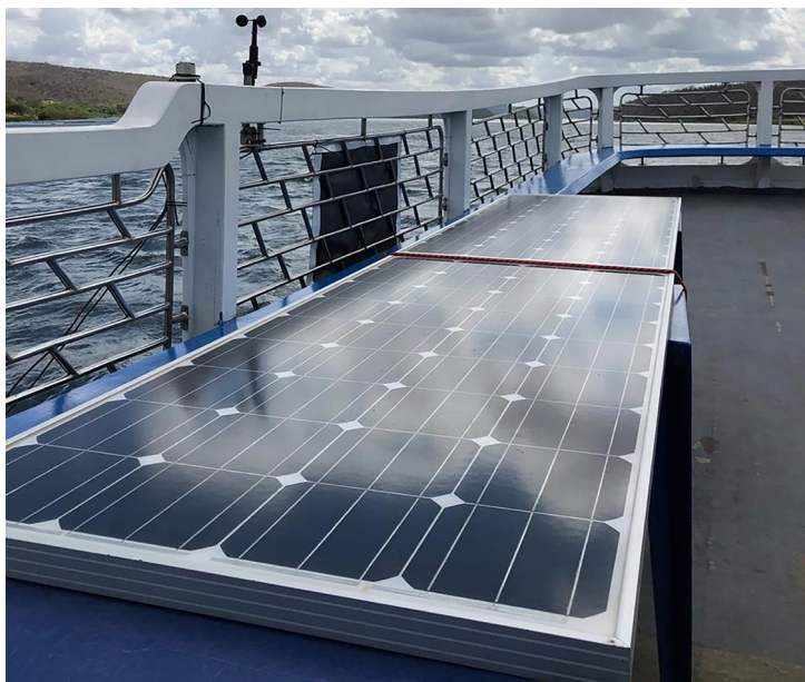
Figura 132 - Módulos fotovoltaicos instalados na II Expedição Científica do Rio São Francisco.
