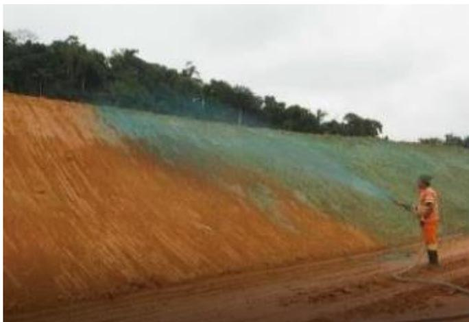
**Figura 23 – Representação da Técnica de Hidrossemeadura.**
