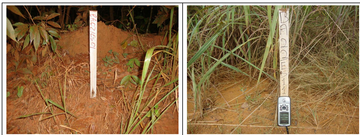
Figura 28 – Locação e estaqueamento.
