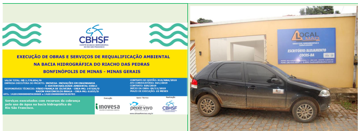
Figura 27 – Placa da Obra e Canteiro/Escritório de obras hidroambientais contratadas pela Agência Peixe Vivo.
