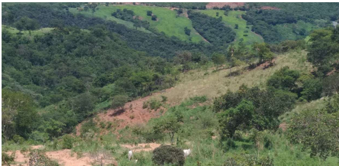
Figura 4.118 – Erosão na Propriedade 34
