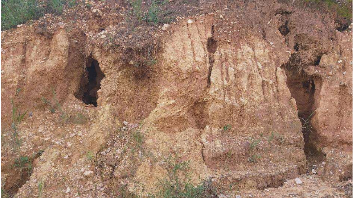
Figura 4.148 – Erosão 01 na Propriedade 43
