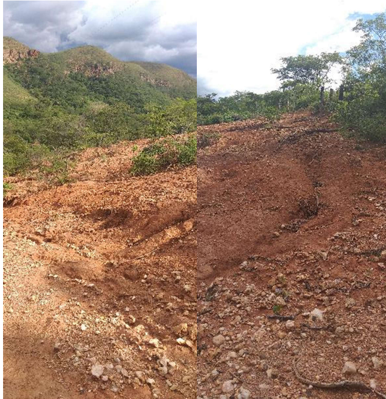
Figura 4.150 – Erosão 03 na Propriedade 43
