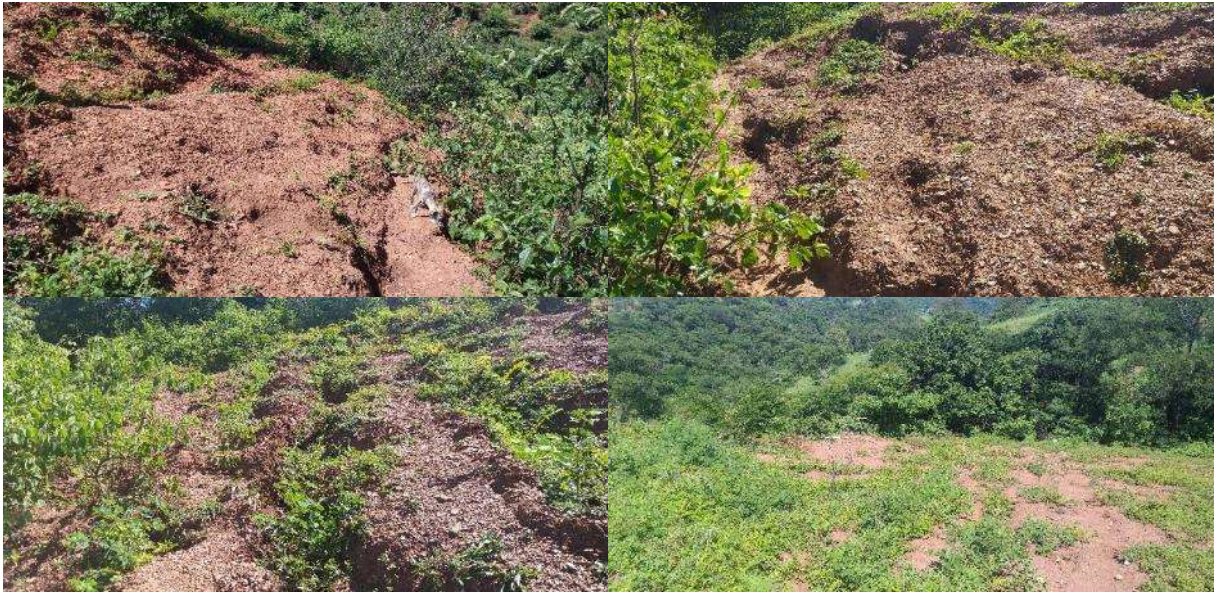
Figura 4.123 – Erosão 02 na Propriedade 35
