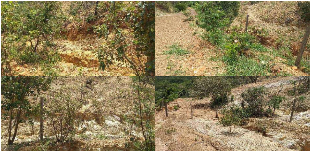
Figura 4.36 – Estrada que passa próximo à propriedade 11 com erosão
