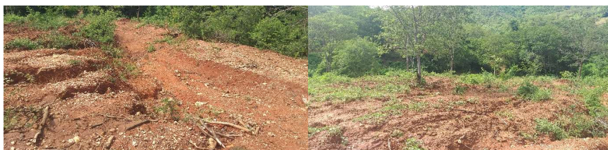
Figura 4.75 – Erosão na Propriedade 23
