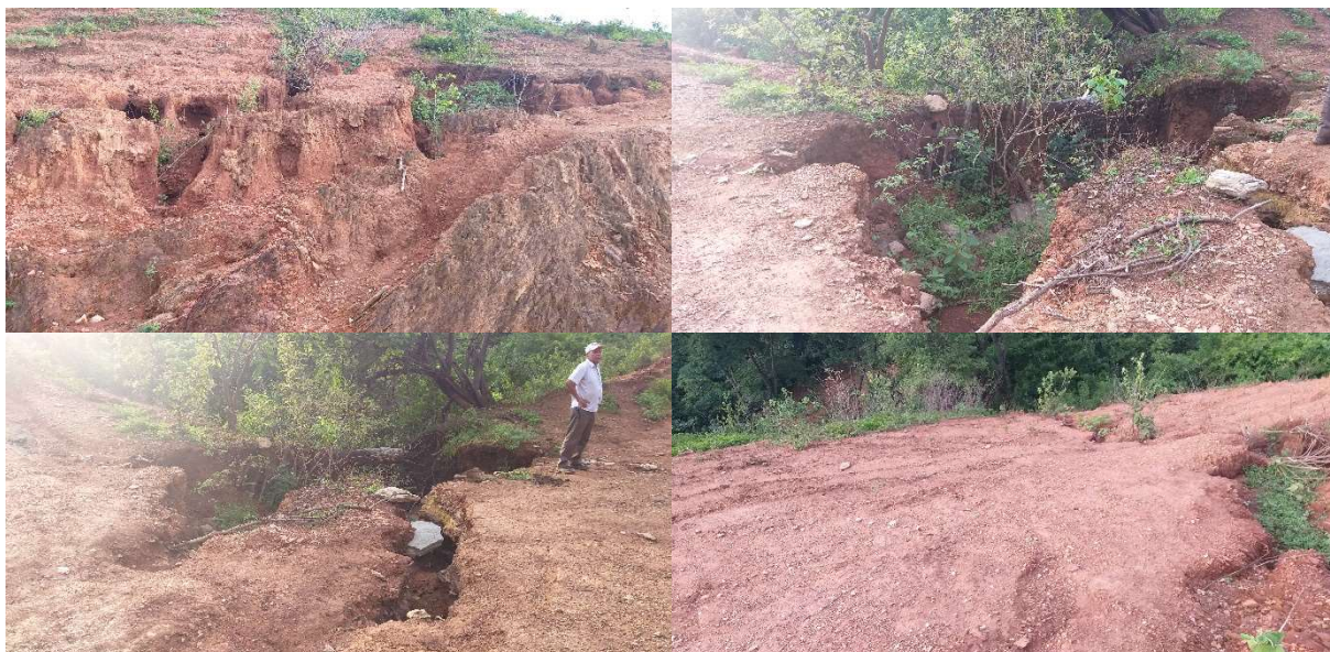
Figura 4.171 – Erosão na Propriedade 48
