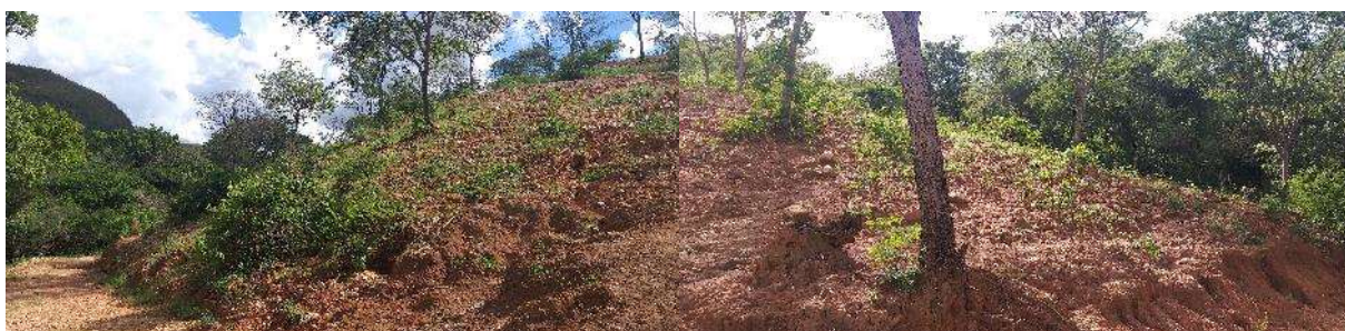
Figura 4.114 – Erosão na Propriedade 33
