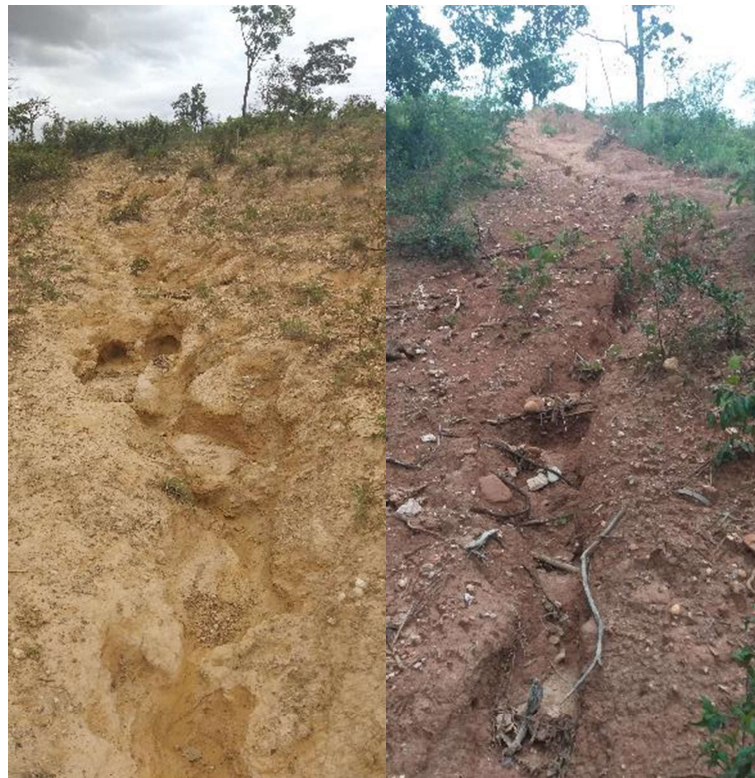
Figura 4.105 – Erosão 01 na Propriedade 31
