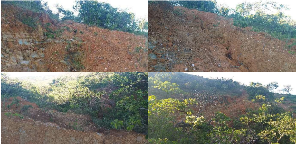
Figura 4.51 – Erosão na Propriedade 16
