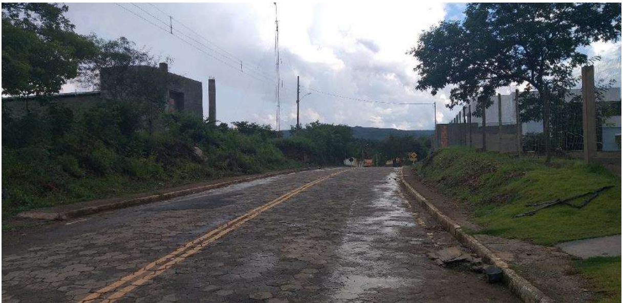
Figura 4.23 – Acesso por estrada pavimentada à Propriedade 7
