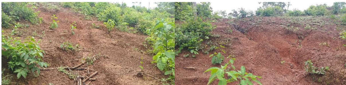
Figura 4.145 – Erosão na Propriedade 42
