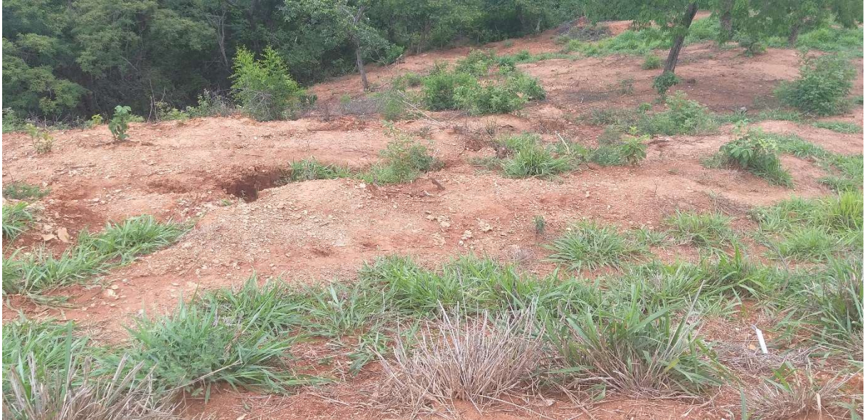
Figura 4.165 – Erosão 01 na Propriedade 47
