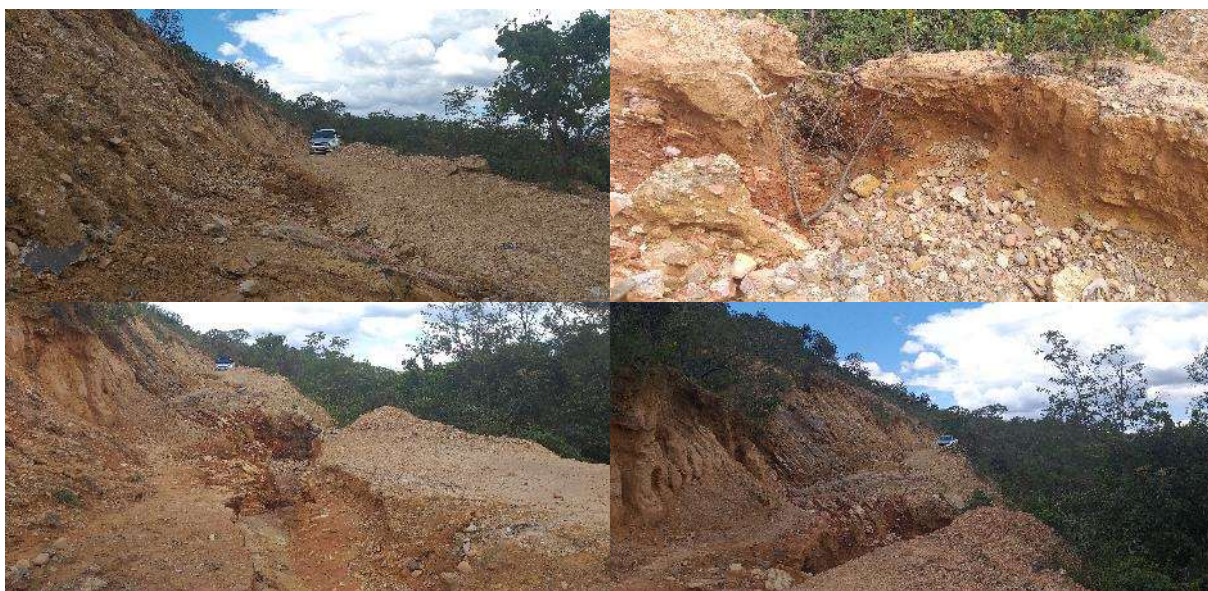
Figura 4.138 – Erosão em estrada que dá acesso à Propriedade 40
