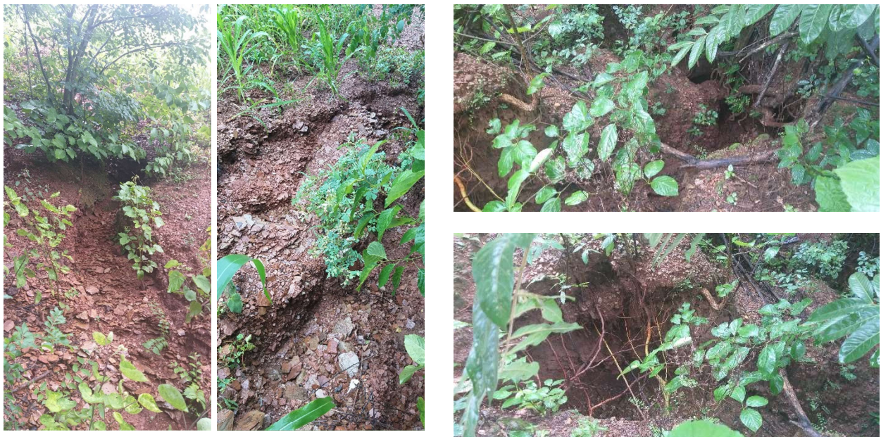
Figura 4.187 – Erosão na Propriedade 54
