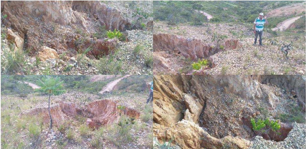
Figura 4.111 – Erosão 02 na Propriedade 32
