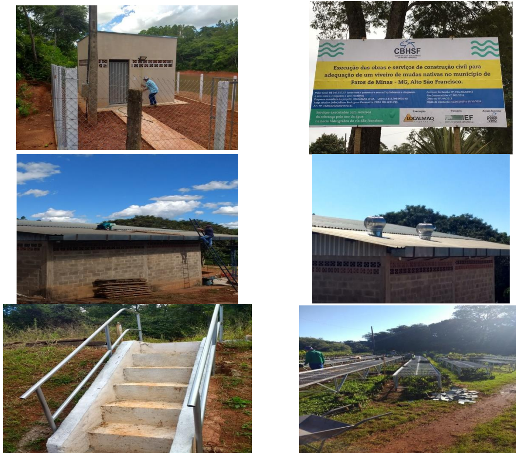
Figura 23 - Acervo fotográfico das obras e serviços de construção civil para adequação de um viveiro de mudas nativas no município de Patos de Minas/MG (Fonte: LOCALMAQ, 2019).
