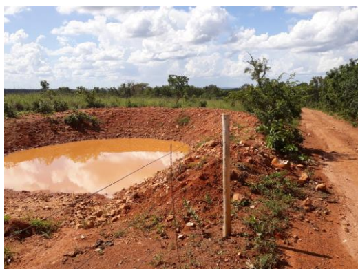
Figura 4 – Bacia de captação de águas das chuvas.
