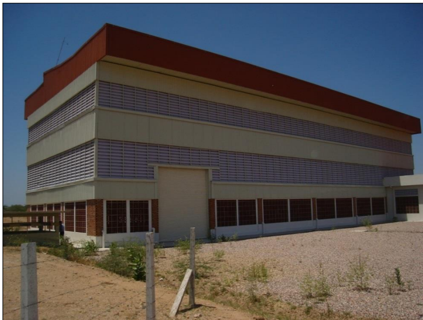
Figura 5 – Estação Elevatória de Água Bruta – vista frontal
