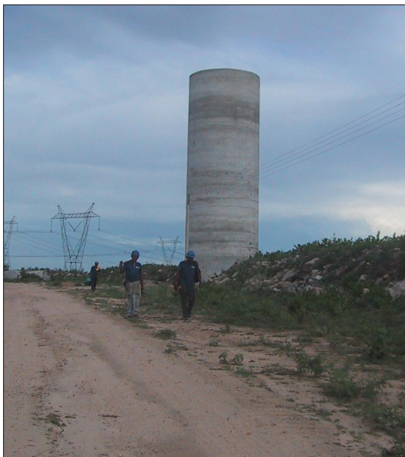
Figura 12 – Linha de Recalque - Chaminé de equilíbrio
