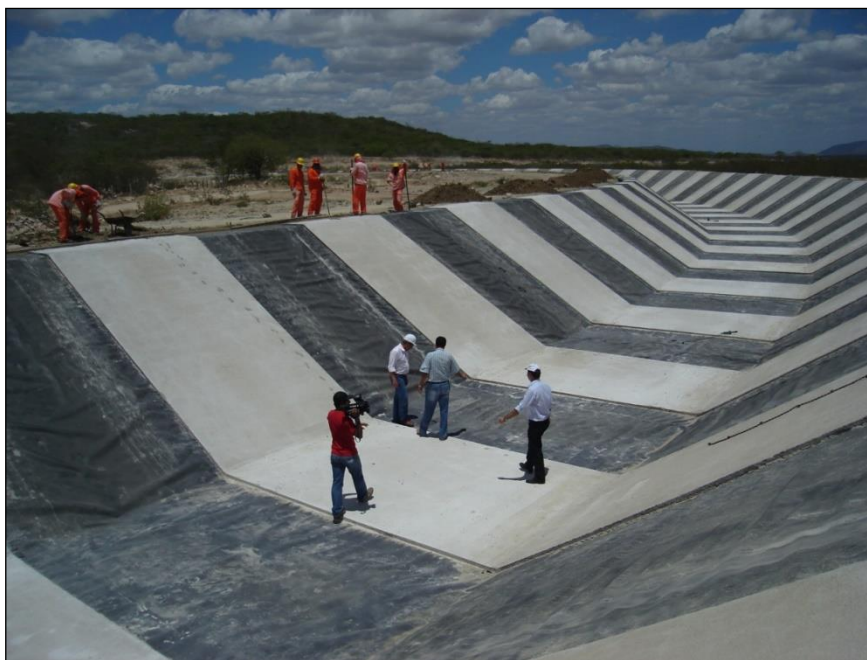
Figura 10 – Canal Adutor em obras – Seção Trapezoidal
