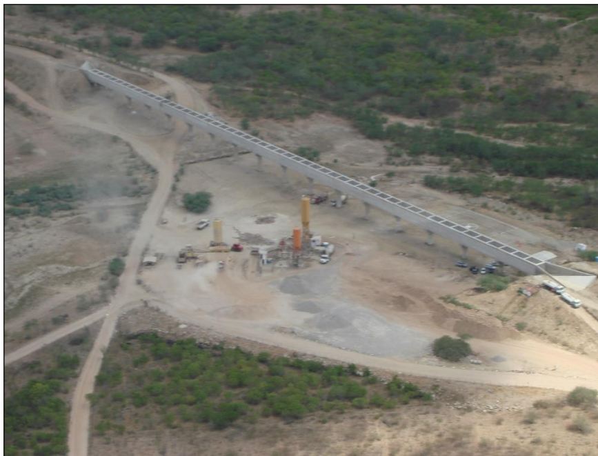
Figura 11 – Canal Adutor - Ponte-Canal em Construção
