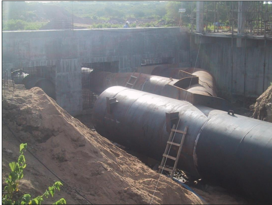
Figura 3 – Estação Elevatória - Barrilete externo montado
