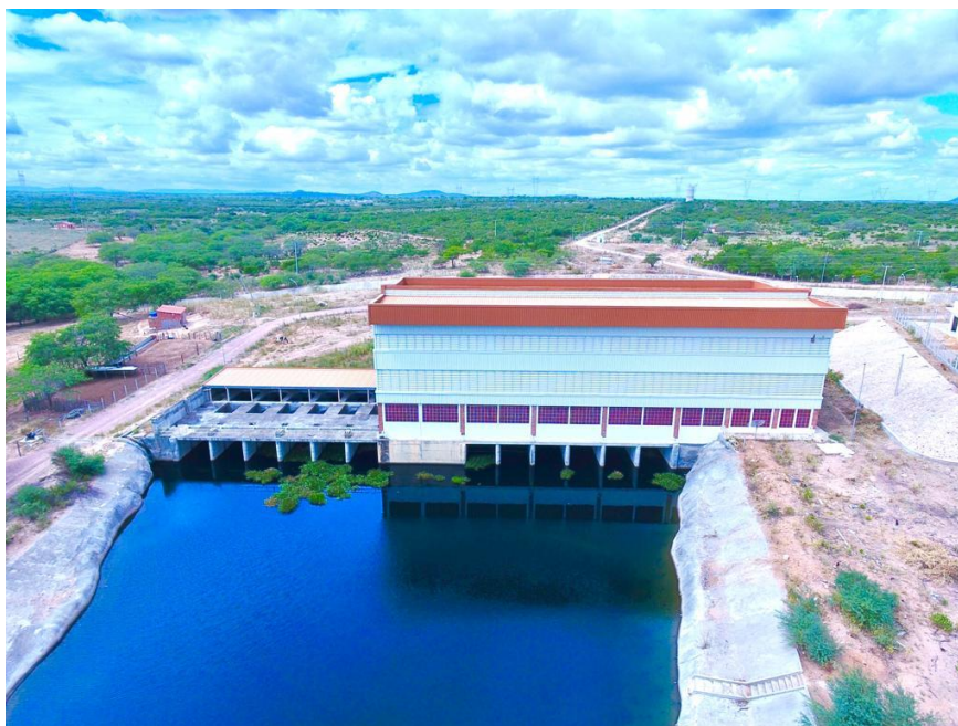
Figura 6 – Estação Elevatória de Água Bruta – vista traseira
