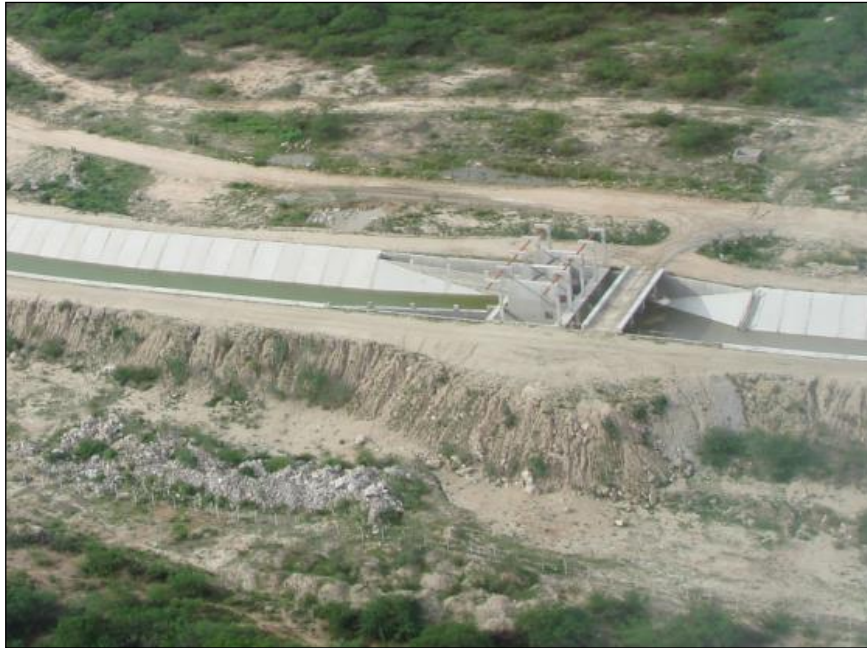
Figura 9 – Canal Adutor - comportas
