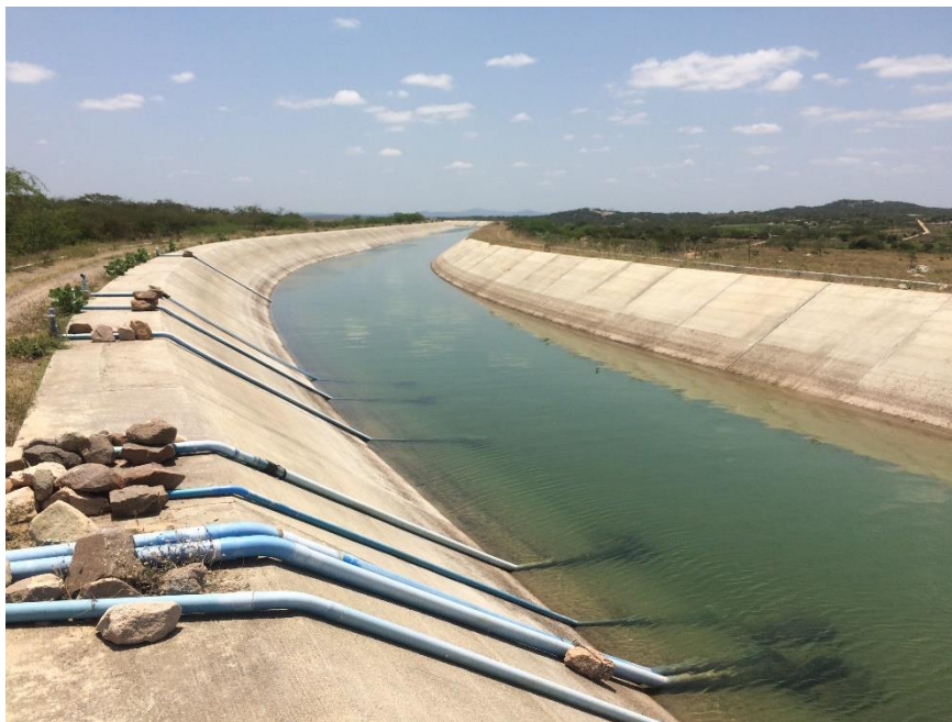
Figura 15 – Captações para irrigação ao longo do Canal do Sertão
