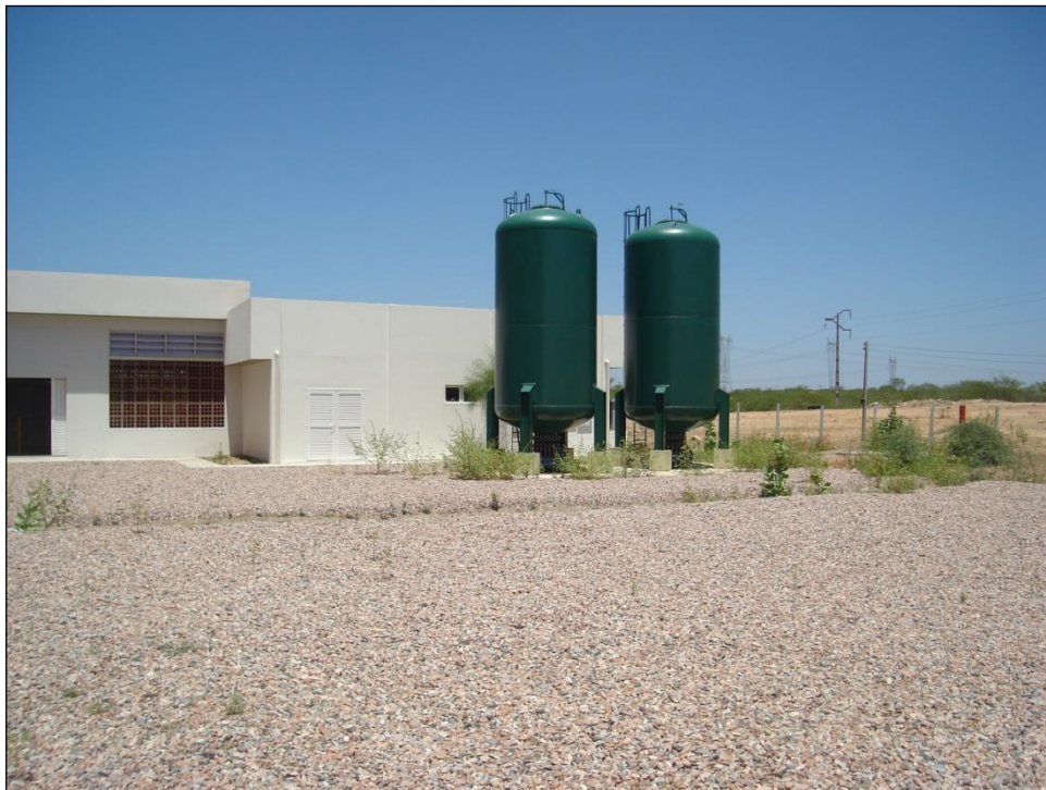
Figura 4 – Linha de Recalque - Vasos de pressão instalados
