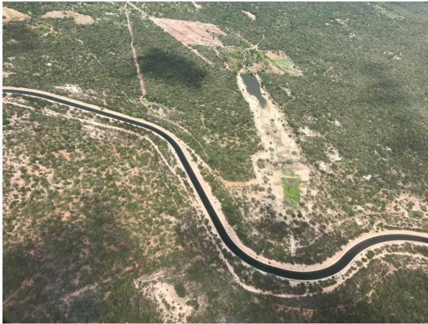
Figura 13 – Água escoando no Canal do Sertão – vista aérea
