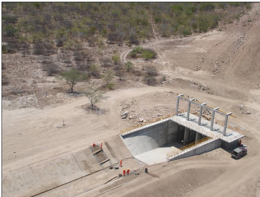
Figura 8 – Estrutura de Transição - Sifão Invertido
