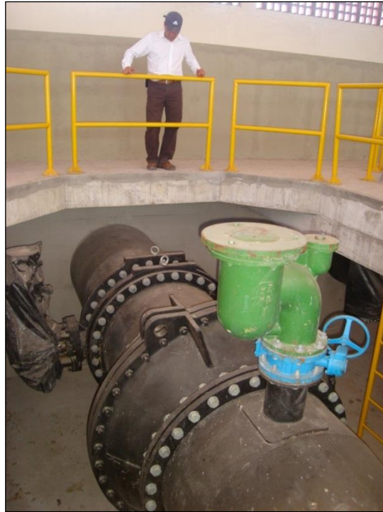
Figura 2 – Estação Elevatória - Barrilete Interno montado
