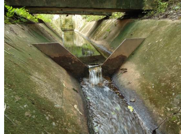
Vertedor triangular na base da barragem
