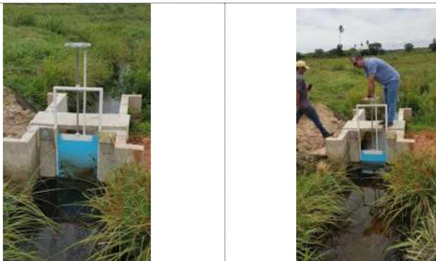
**Figura 19 - Acervo fotográfico das obras e serviços de implantação do sistema de comportas hidráulicas em canais de irrigação no Perímetro Irrigado do Vale do Rio Paramirim, Estado da Bahia, Médio São Francisco.**
