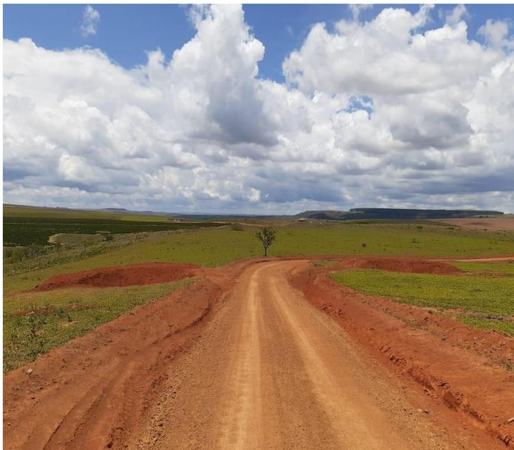
Figura 03: Exemplo de estrada vicinal com duas barraginhas de captação de água de enxurrada.
