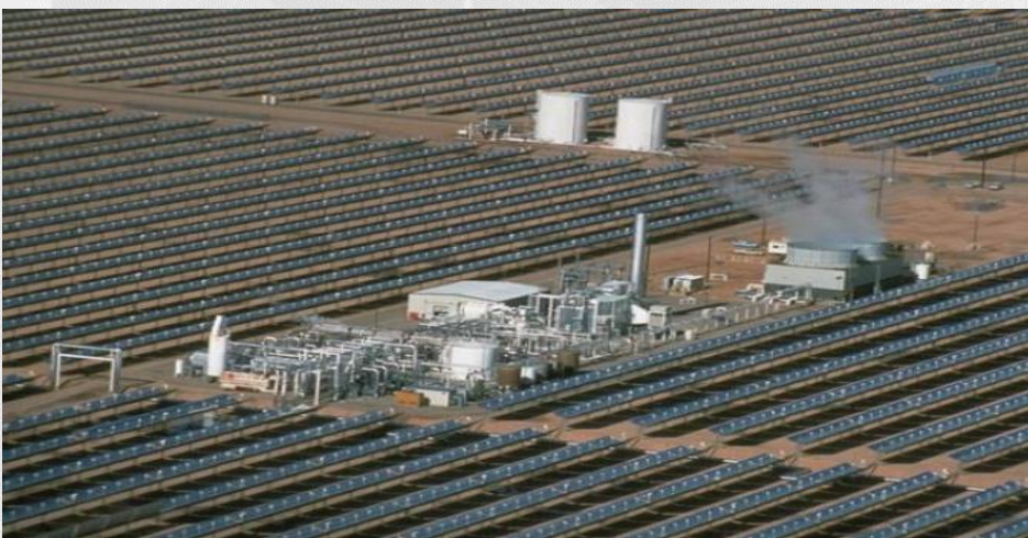
Cilindro: Solar Electric Generation Station - SEGS - 354 MW (9 unidades), deserto de Mojave, USA
