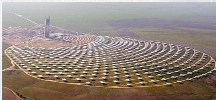
Torre: planta PS10 (11 MW, com armazenamento de energia), Espanha, Sevilla.
