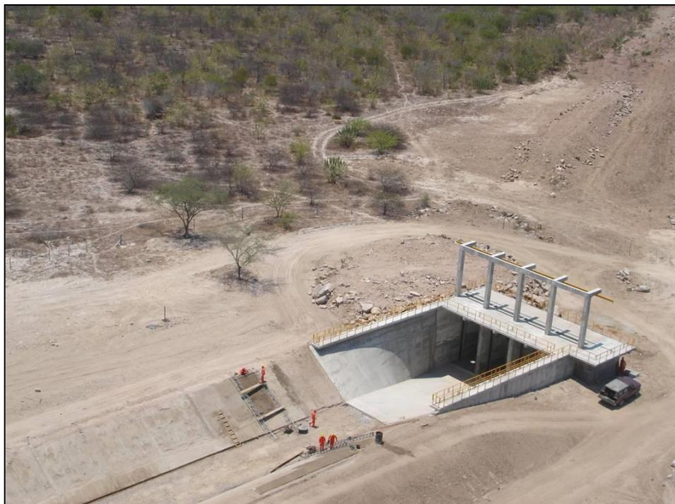
Figura 8 – Estrutura de Transição - Sifão Invertido
