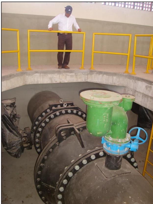
Figura 2 – Estação Elevatória - Barrilete Interno montado
