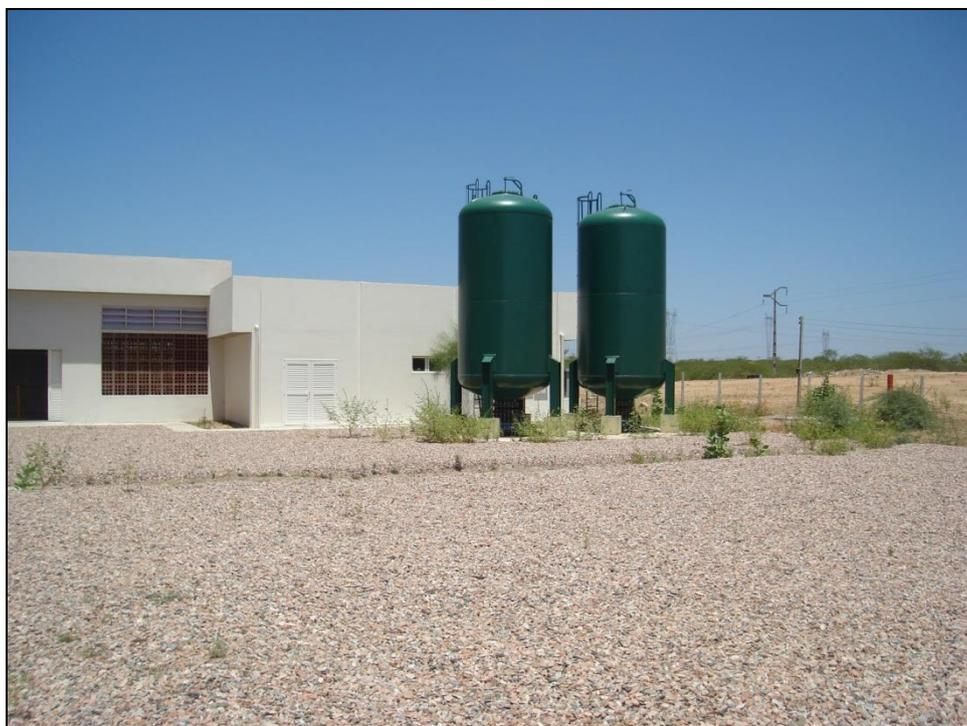
Figura 4 – Linha de Recalque - Vasos de pressão instalados
