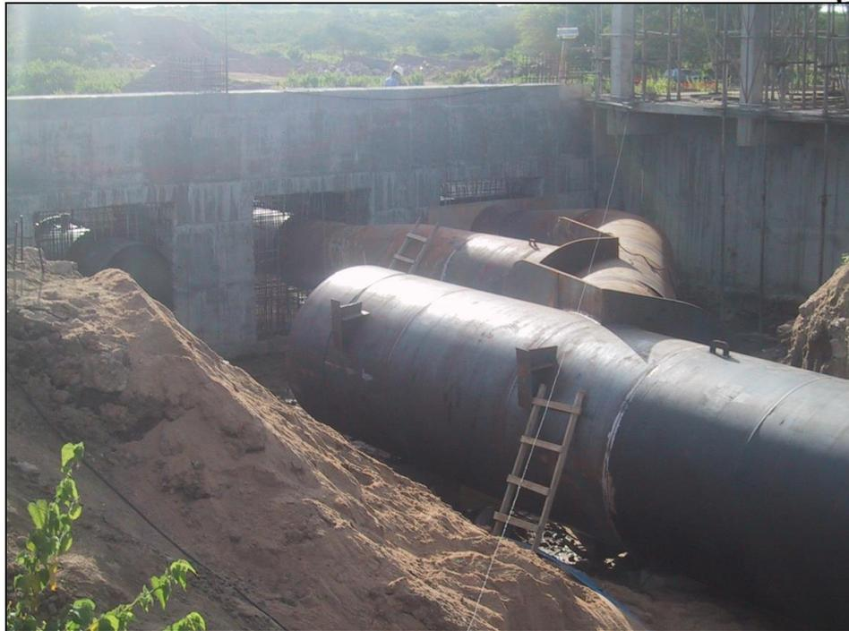
Figura 3 – Estação Elevatória - Barrilete externo montado
