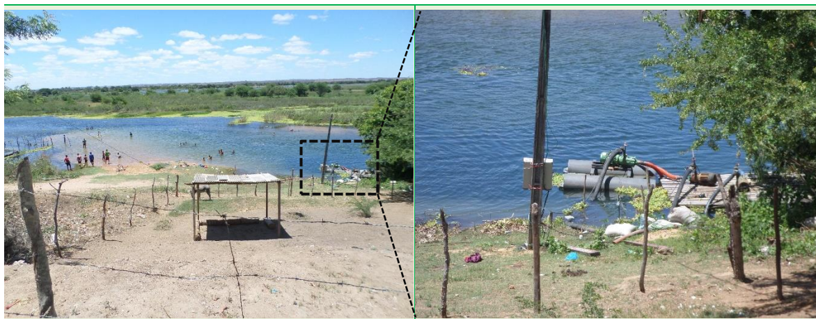
Figura 17 – Pontos de acumulação de lixo na captação superficial de água.
