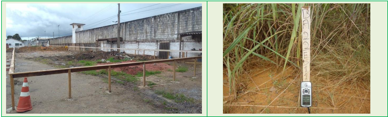
Figura 25 – Locação, gabarito e estaqueamento.
