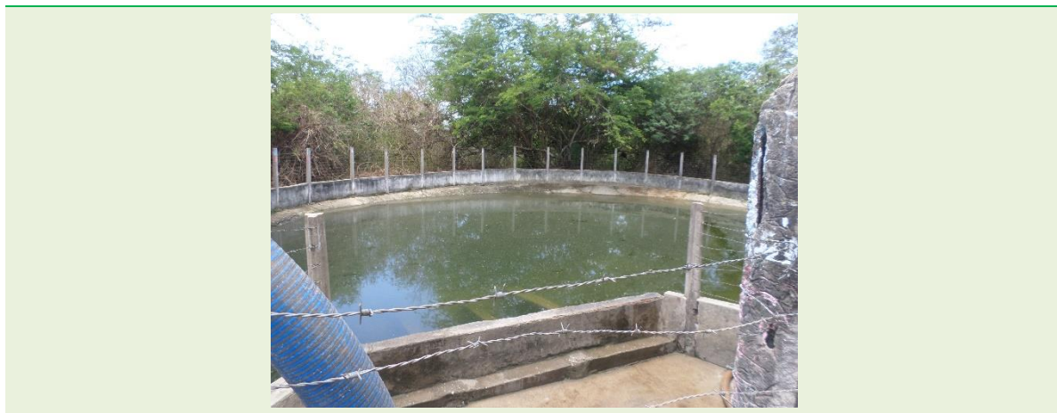
Figura 19 – Pontos observados de acumulação superficial de água.
