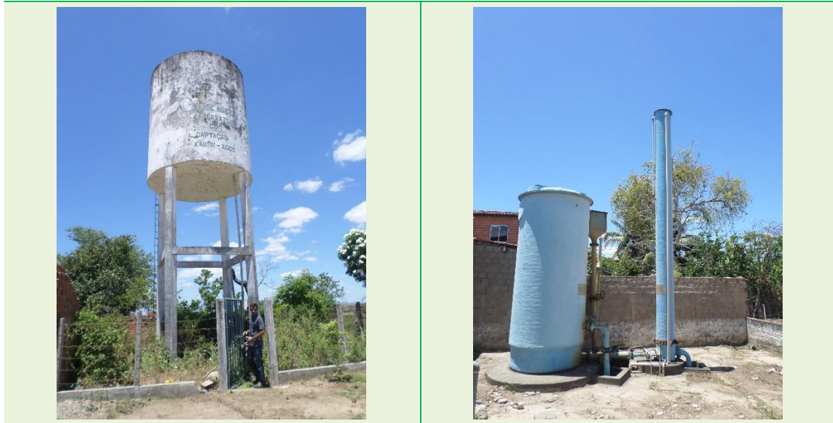
Figura 18 – Pontos de acumulação superficial de água
