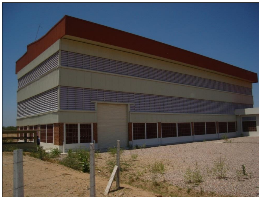
Figura 5 – Estação Elevatória de Água Bruta – vista frontal
