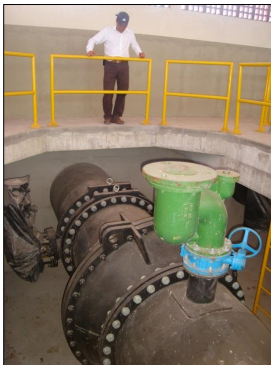
Figura 2 – Estação Elevatória - Barrilete Interno montado
