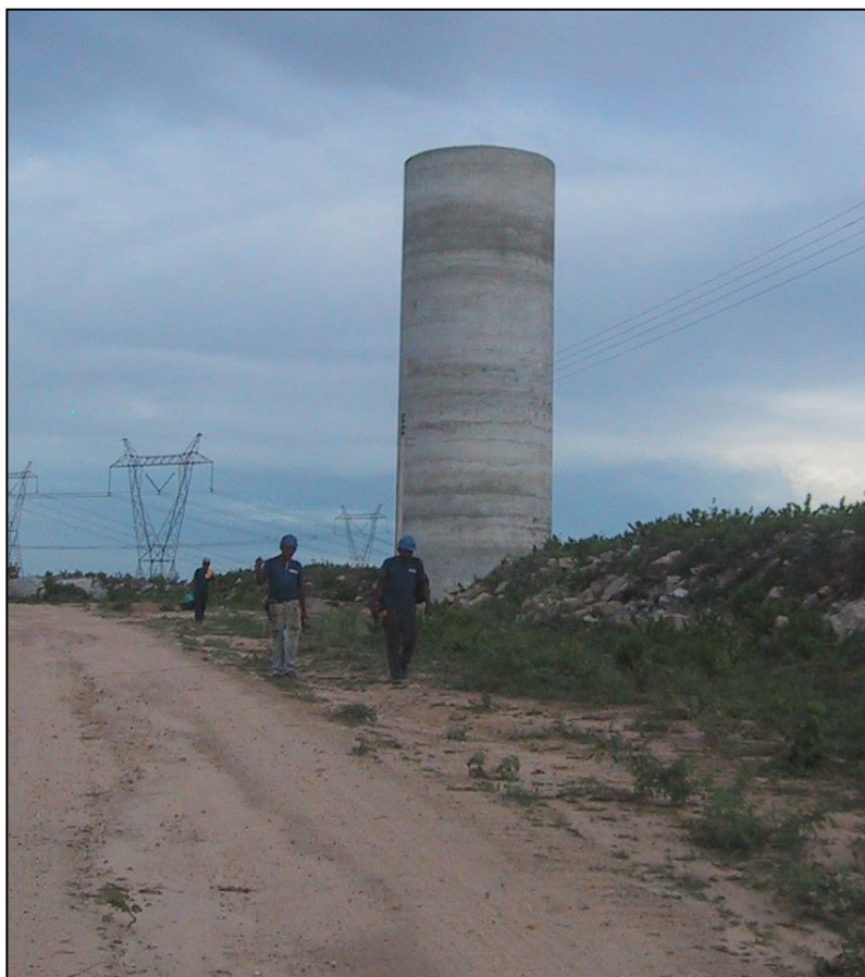
Figura 12 – Linha de Recalque - Chaminé de equilíbrio
