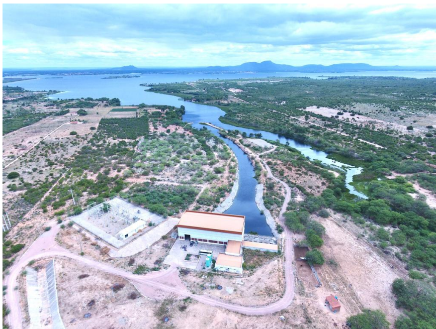
Figura 7 – Estação Elevatória – Ensecadeira e canal de aproximação – vista aérea
