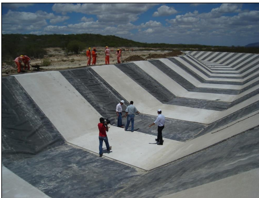
Figura 10 – Canal Adutor em obras – Seção Trapezoidal
