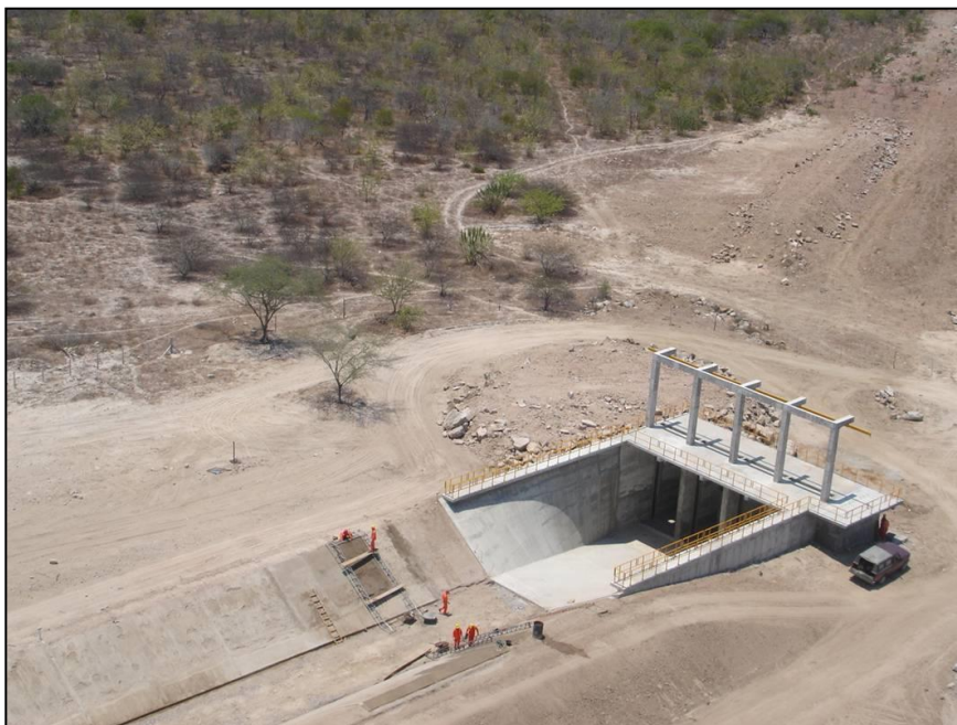
Figura 8 – Estrutura de Transição - Sifão Invertido
