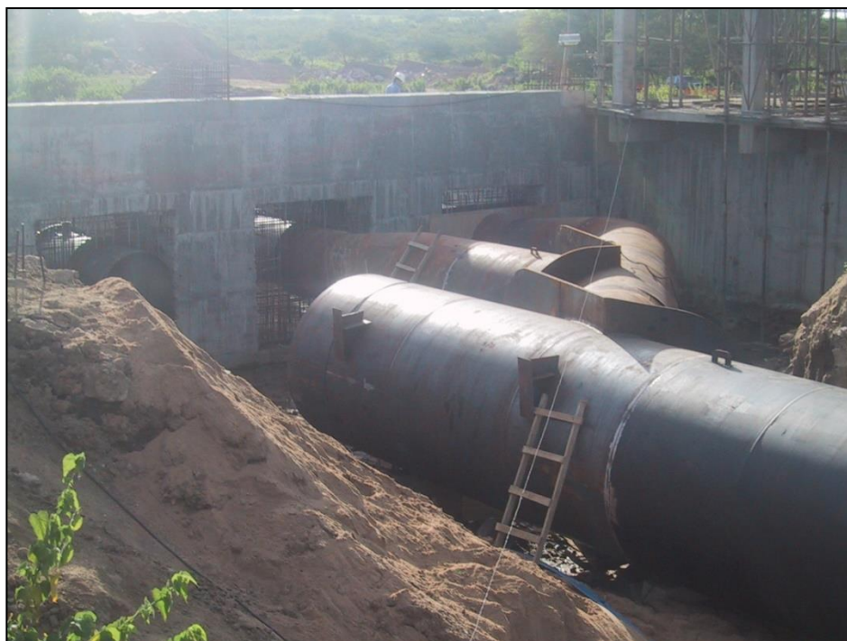
Figura 3 – Estação Elevatória - Barrilete externo montado
