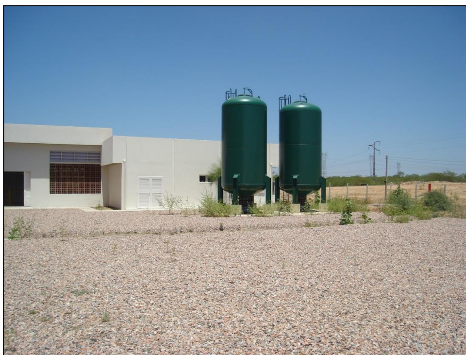
Figura 4 – Linha de Recalque - Vasos de pressão instalados
