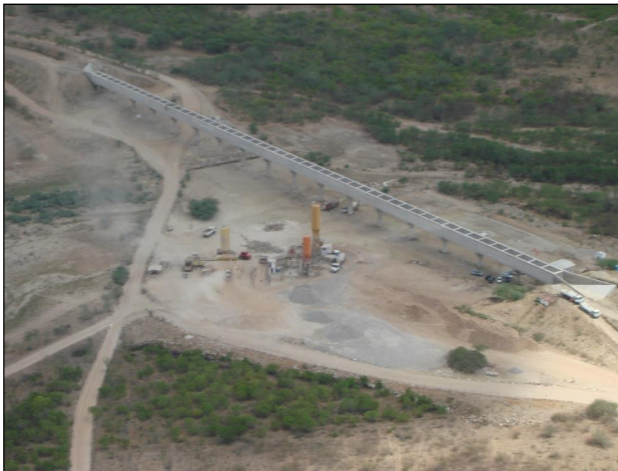
Figura 11 – Canal Adutor - Ponte-Canal em Construção
