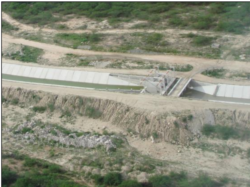
Figura 9 – Canal Adutor - comportas
