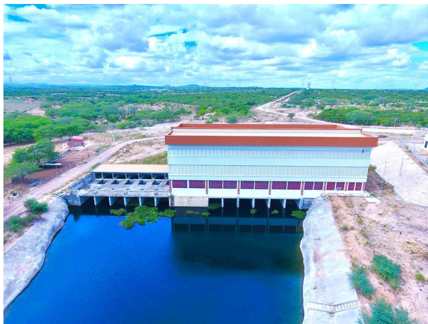
Figura 6 – Estação Elevatória de Água Bruta – vista traseira
