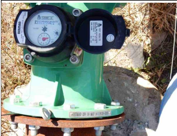
Figura 12 – Hidrômetro do ponto 2 nº 5385 (177.432m³)
