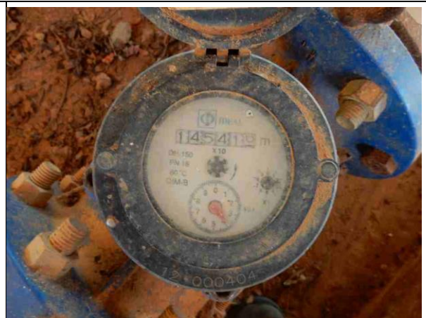
Figura 11 – Hidrômetro sazonal nº404 (1.454.162 m³).
