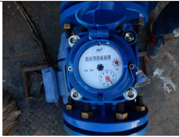
Figura 1 - Hidrômetro instalado (509,44 m 3 ).
