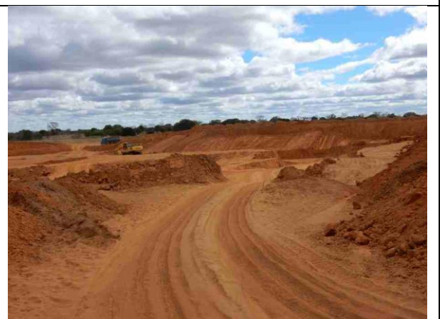
Figura 47 – Construção de reservatório.
