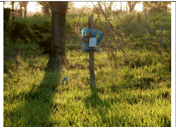
Figura 33 – Painel de controle dos aspersores.
