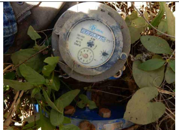
Figura 28 - Hidrômetro 3, flange nº436 (6.663.752,8 m³)
