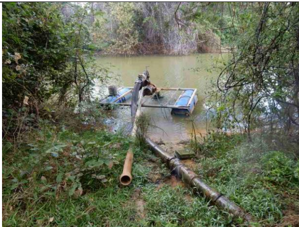
Figura 40 – Captação sem outorga.
