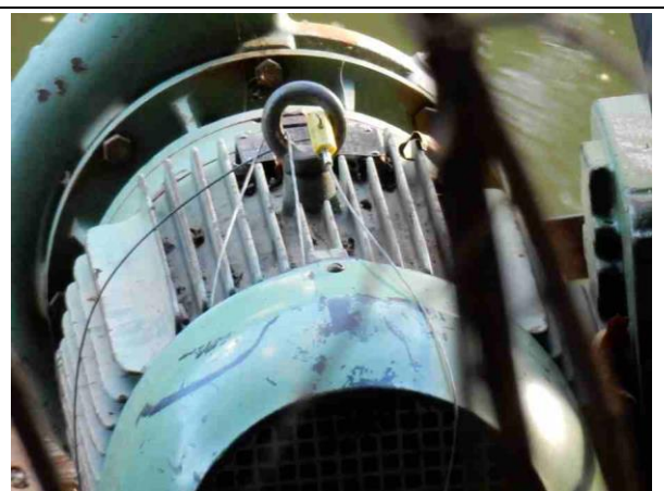
Figura 49 – Bomba com lacres intactos.
