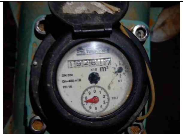
Figura 5 – Hidrômetro 1, nº0194 (1.926.177,7 m³)
