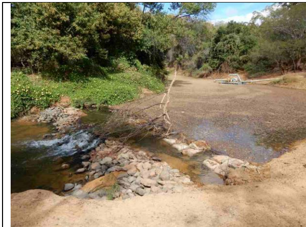
Figura 44 – Captação e barramento.
