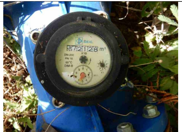
Figura 26 - Hidrômetro 1, flange nº414 (3.721.289,6 m³).
