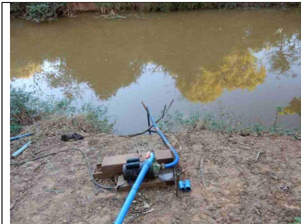
Figura 32 – Bomba captando do rio.
