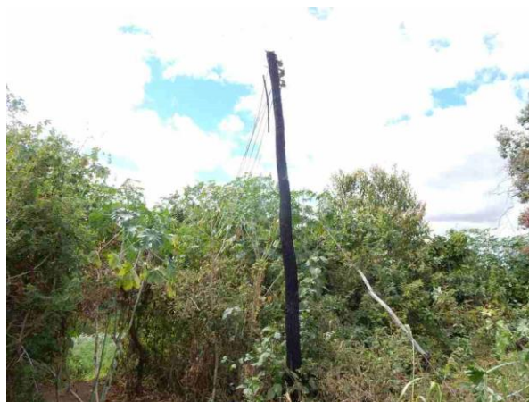
Figura 51 – Poste sem painel de energia.
