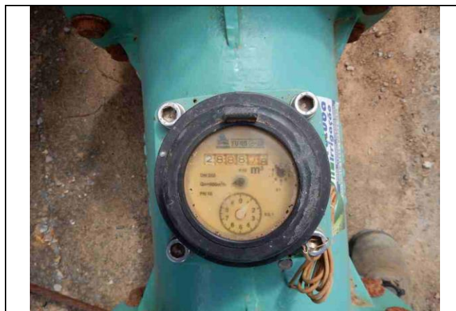
Figura 55 – Hidrômetro (2.888.789,1 m 3 )
