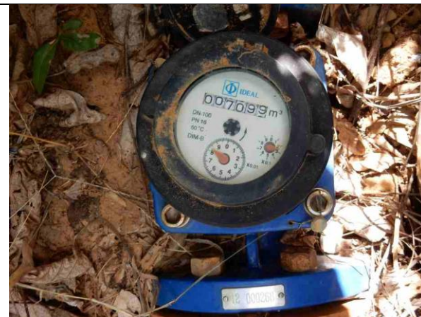
Figura 27 - Hidrômetro 2, flange nº268 (07.099,28 m³)
