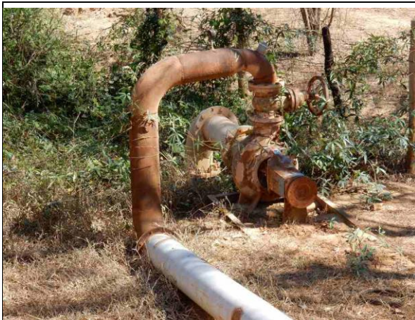
Figura 8 – Conjunto motobomba sem motor.
