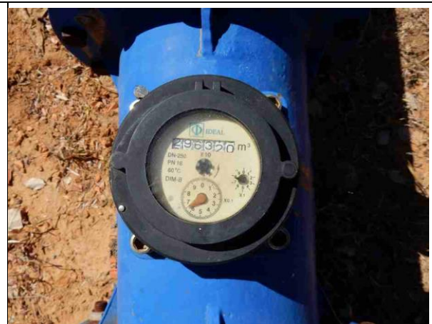
Figura 9 – Hidrômetro flange nº0450 (2.963.207,6 m³)
