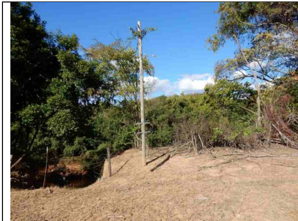
Figura 34 – Transformador e painel de comando retirados.
