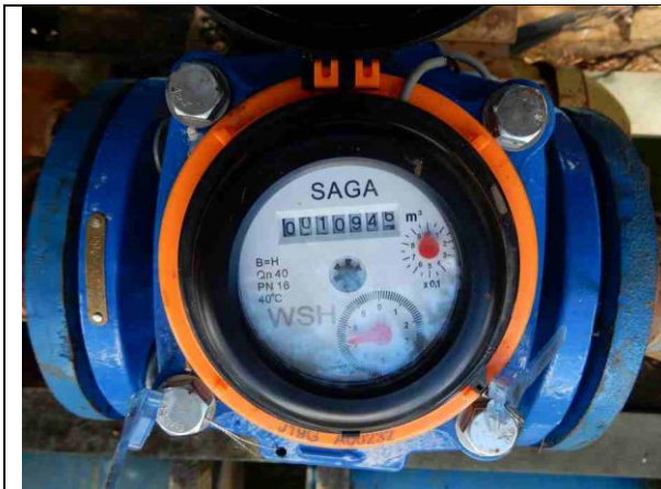
Figura 36 – Hidrômetro, flange nº 232 (10.946,97 m³).
