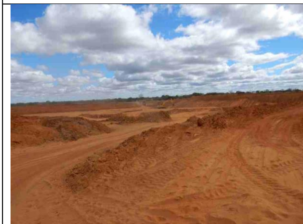
Figura 46 – Movimentação de terra para construção de reservatório.
