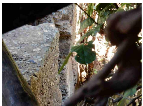
Figura 15 – Barramento 2 quebrado parcialmente.
