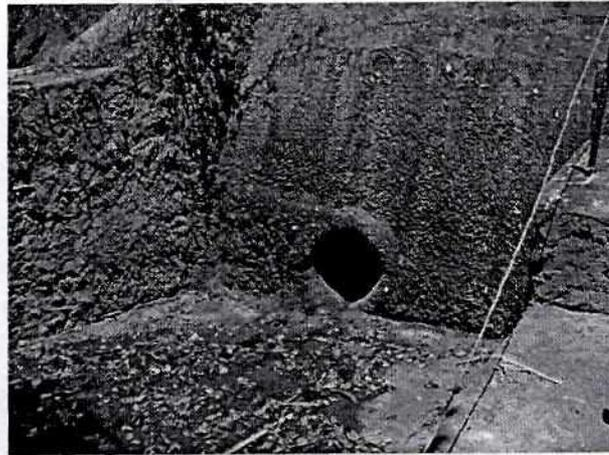
Figura 27 - Descarga de fundo inutilizada.
