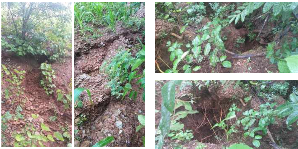
Figura 8.262 – Erosão na Propriedade 54
