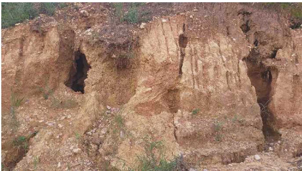
Figura 8.213 – Erosão 01 na Propriedade 43
