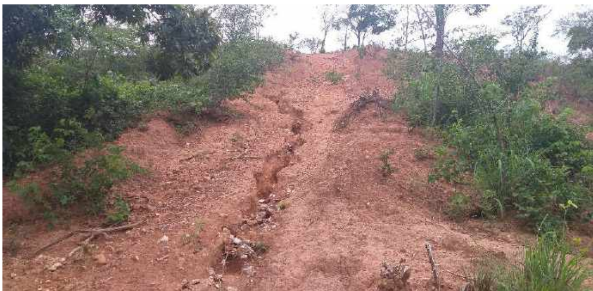
Figura 8.159 – Erosão 02 na Propriedade 31
