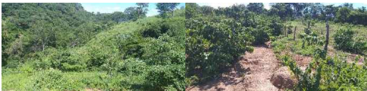
Figura 8.179 – Erosão 01 na Propriedade 35
