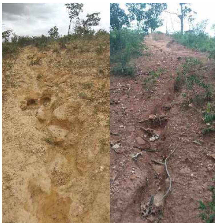
Figura 8.158 – Erosão 01 na Propriedade 31
