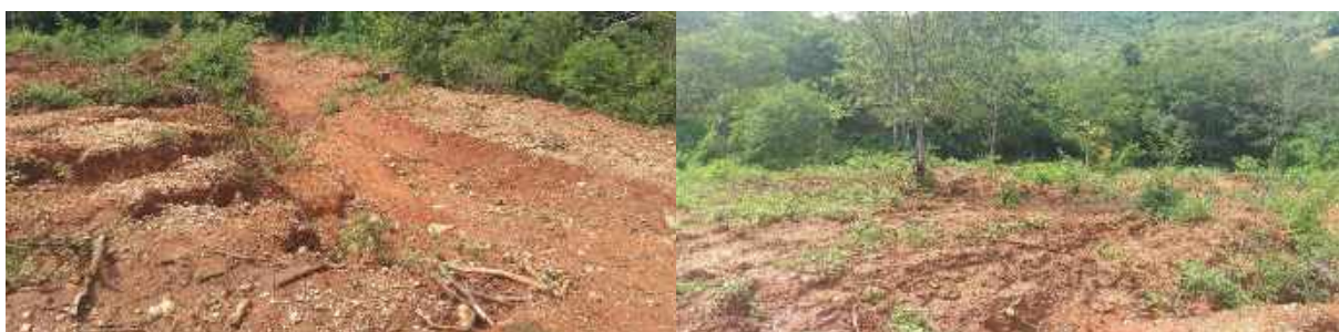
Figura 8.120 – Erosão na Propriedade 23
