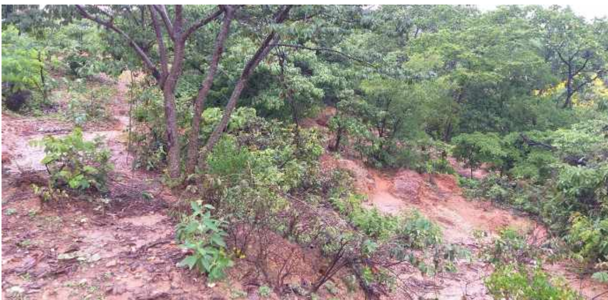
Figura 8.267 – Erosão na Propriedade 55
