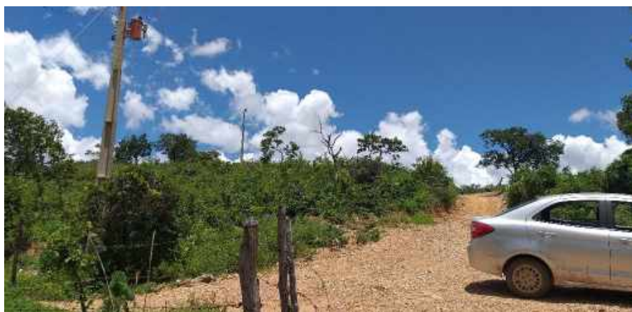
Figura 8.293 – Estrada não pavimentada, em estado crítico, de acesso à Propriedade 38
