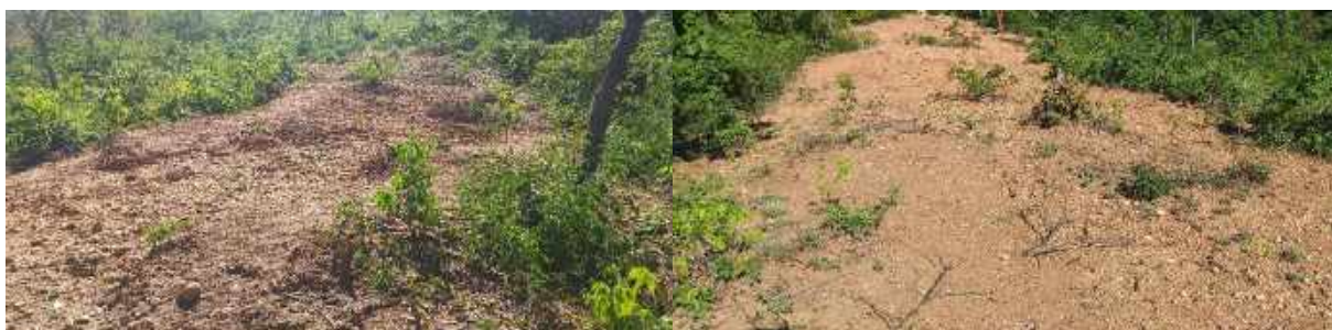
Figura 8.75 – Erosão na Propriedade 13
