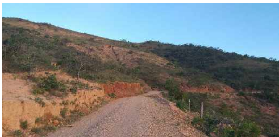
Figura 8.292 – Estrada não pavimentada, em estado crítico, de acesso à Propriedade 32
