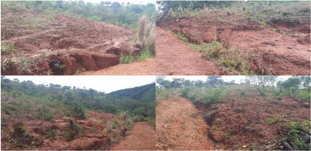
Figura 8.95 – Erosão na Propriedade 18
