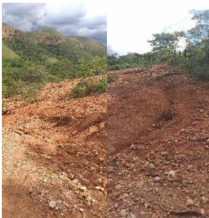
Figura 8.294 – Estrada vicinal, em estado crítico, de acesso à Propriedade 43
