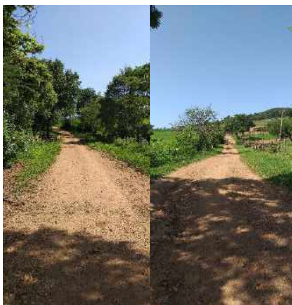
Figura 8.27 – Estrada de acesso à Propriedade 1 em bom estado de conservação
