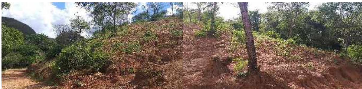
Figura 8.169 – Erosão na Propriedade 33
