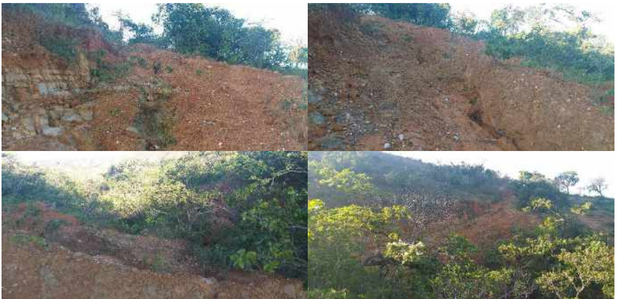
Figura 8.88 – Erosão na Propriedade 16
