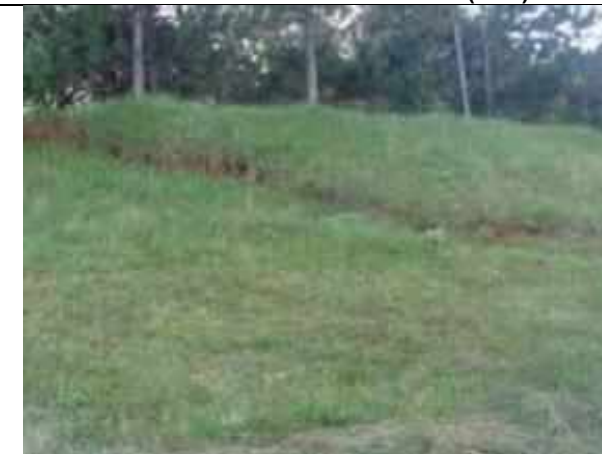
Figura 8.21 - Foto ilustrativa demonstrando uma superfície suave anteriormente desnuda já em processo avançado de cobertura vegetal com espécies herbáceas Fonte: TRIUNFO CONCEPA (2018)
