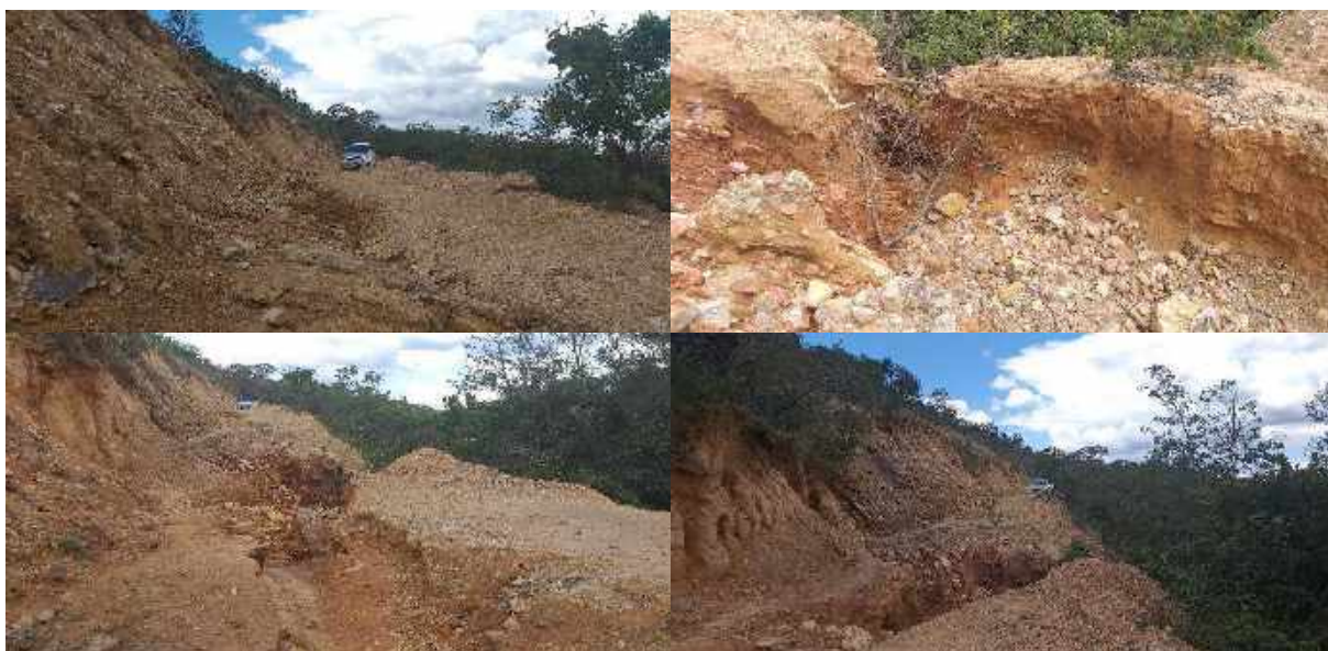
Figura 8.200 – Erosão em estrada que dá acesso à Propriedade 40
