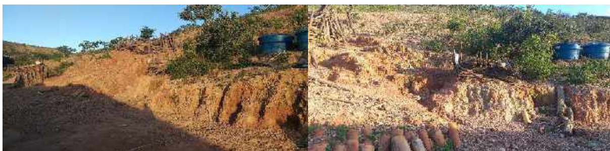
Figura 8.164 – Erosão 01 na Propriedade 32
