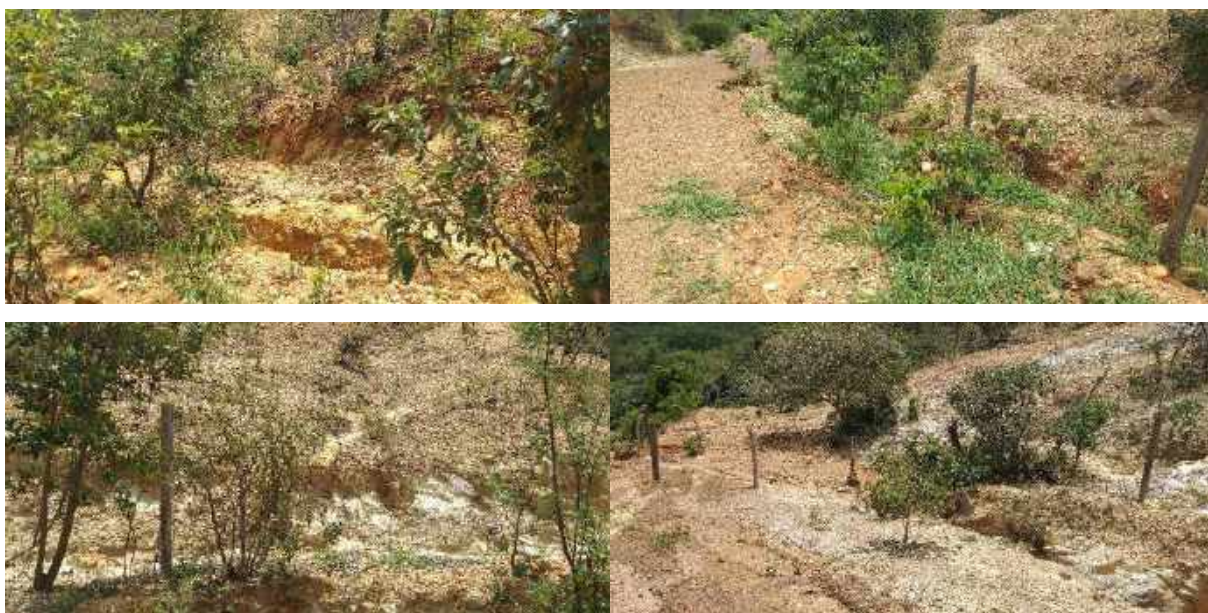
Figura 8.287 – Estrada não pavimentada, em estado crítico, que passa pelas Propriedades 11 e 53
