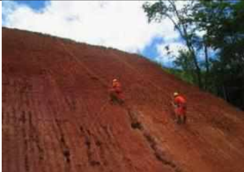
Figura 8.16 – Foto ilustrativa demonstrando a operação de coveamento em superfície de talude desnudo Fonte: LAN GEOTECNIA E FUNDAÇÃO (2020)
