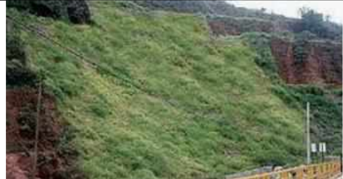
Figura 8.17 – Foto ilustrativa demonstrando um talude anteriormente desnudo já revegetado com espécies herbáceas Fonte: DNIT (2006)
