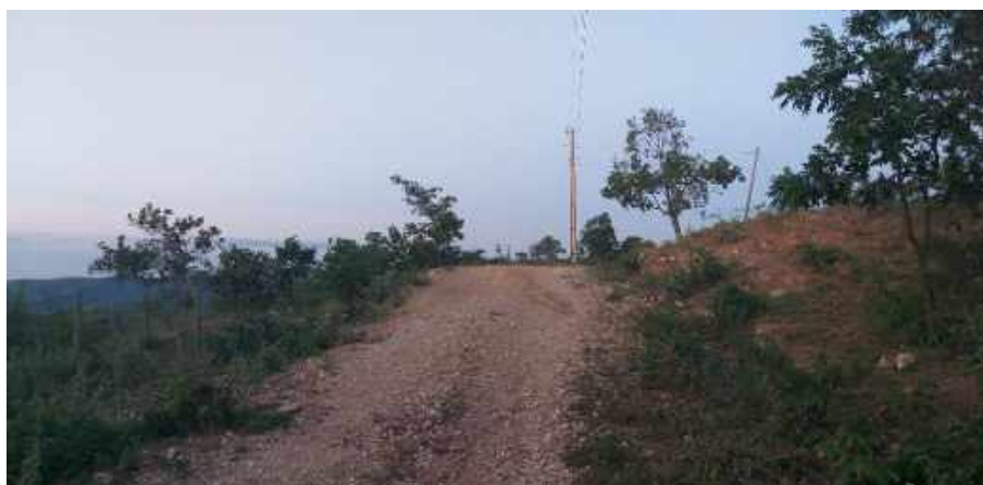
Figura 8.291 – Estrada não pavimentada, em estado crítico, de acesso à Propriedade 25
