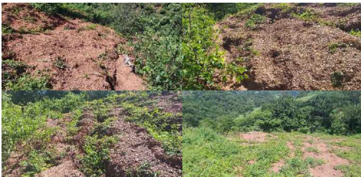
Figura 8.180 – Erosão 02 na Propriedade 35
