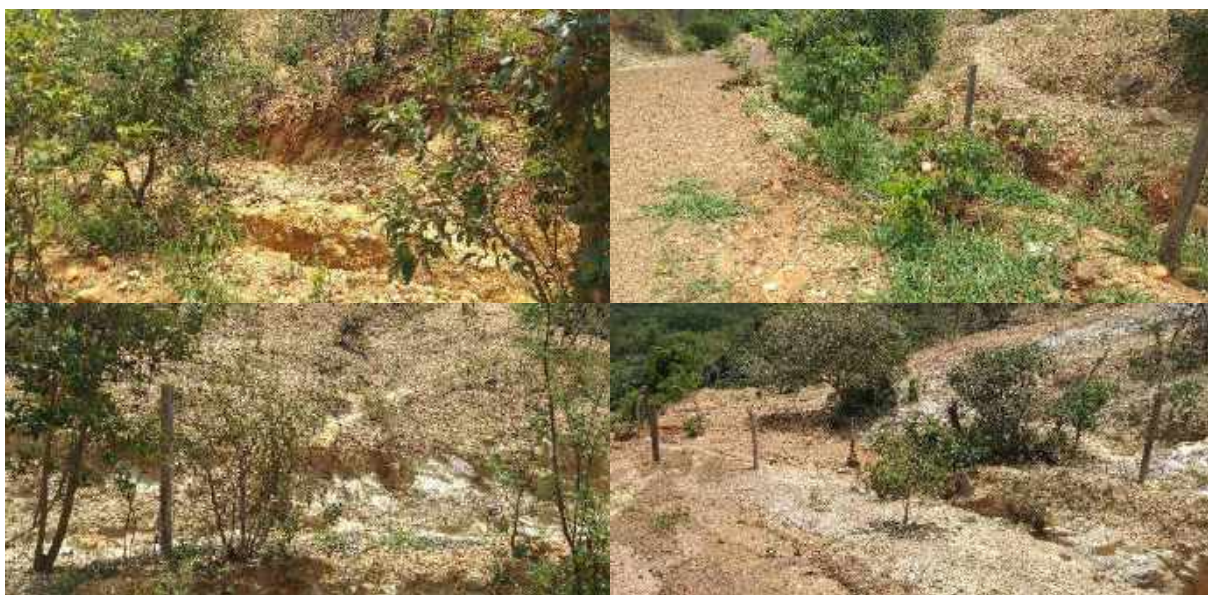
Figura 8.68 – Estrada que passa próximo à propriedade 11 com erosão
