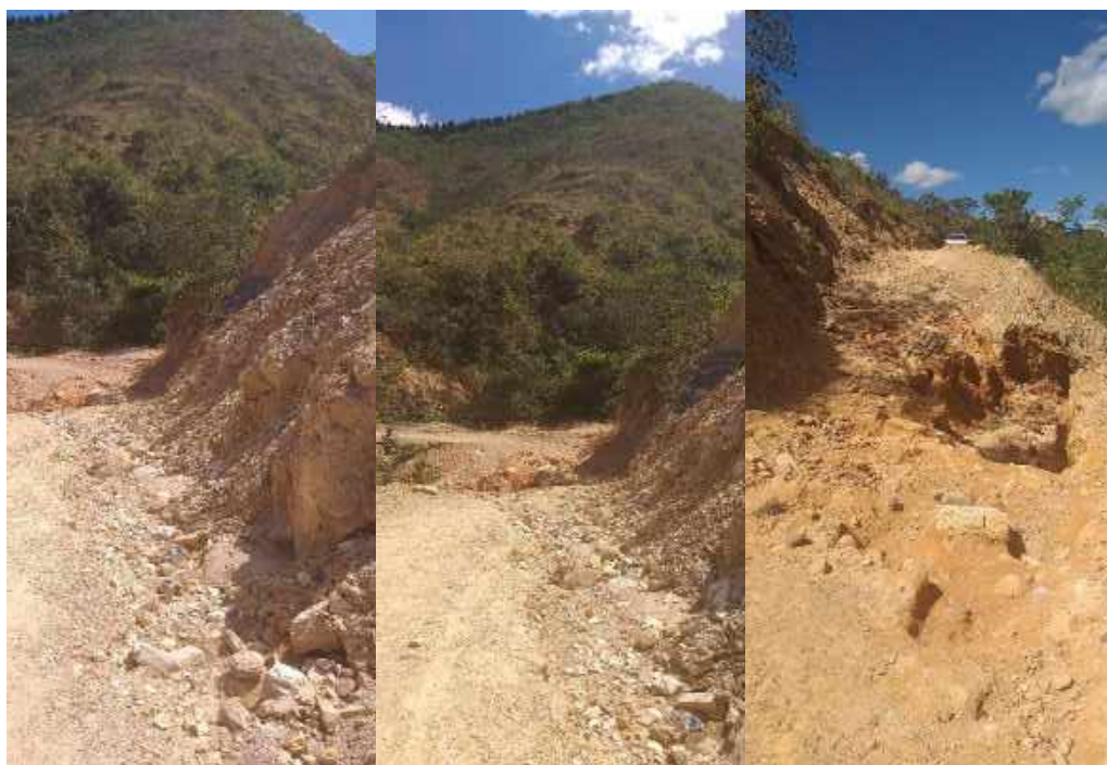
Figura 8.295 – Estrada não pavimentada, em estado crítico, de acesso à Propriedade 45
