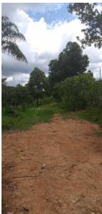
Figura 8.288 – Estrada não pavimentada, em estado crítico, de acesso à Propriedade 13
