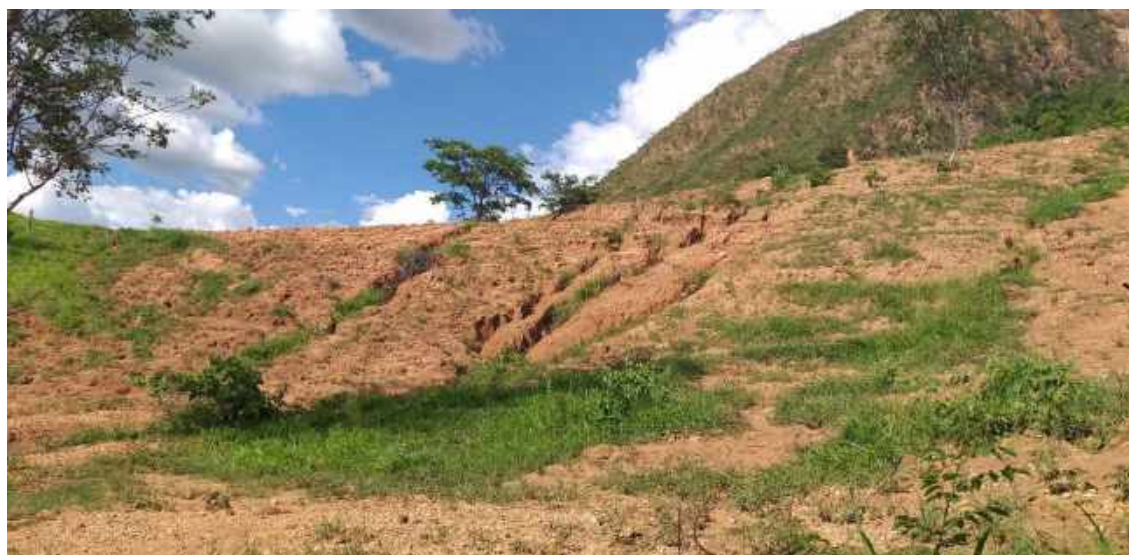
Figura 8.201 – Erosão na Propriedade 40
