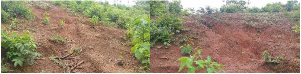
Figura 8.209 – Erosão na Propriedade 42
