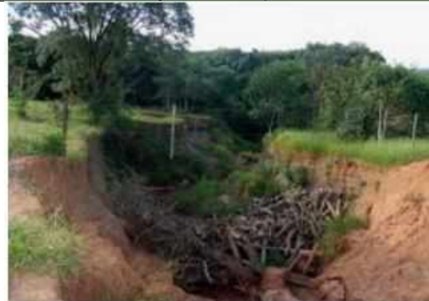
Figura 8.22 – Foto ilustrativa demonstrando o lançamento de material lenhoso da ravina Fonte: WIKIPEDIA (2020)
