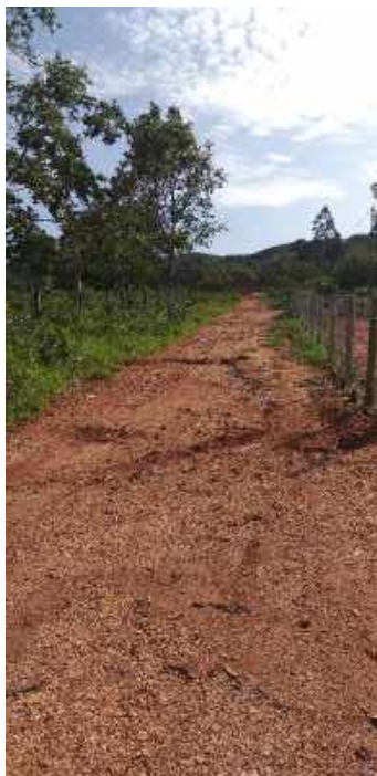
Figura 8.286 – Estrada não pavimentada, em estado crítico, de acesso à Propriedade 9
