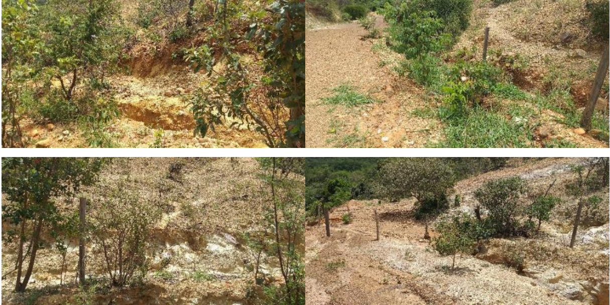
Figura 4.84 – Estrada não pavimentada, em estado crítico, que passa pelas Propriedades 11 e 53
