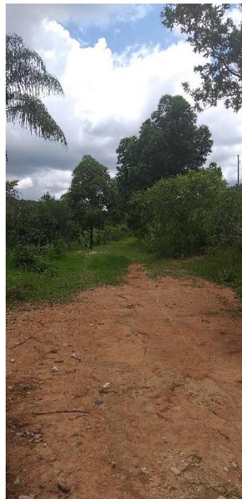
Figura 4.85 – Estrada não pavimentada, em estado crítico, de acesso à Propriedade 13
