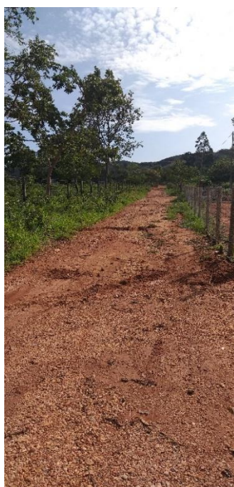
Figura 4.83 – Estrada não pavimentada, em estado crítico, de acesso à Propriedade 9
