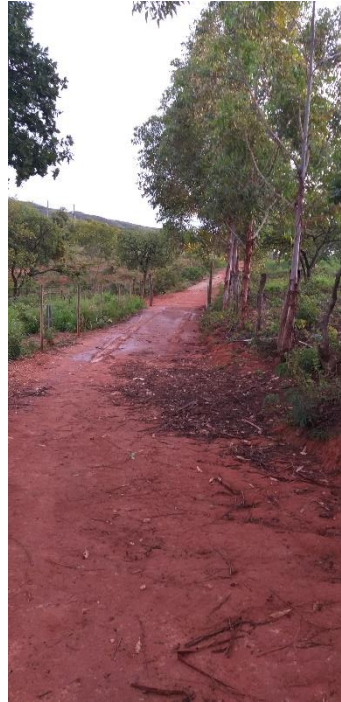
Figura 4.94 – Estrada não pavimentada, em estado crítico, de acesso à Propriedade 53
