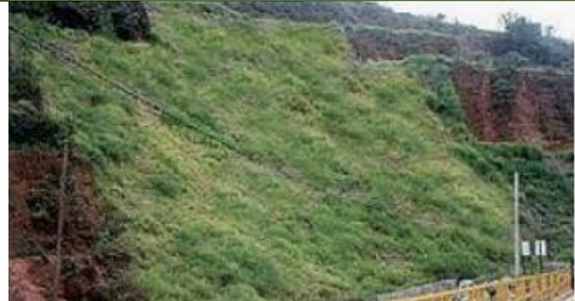
Figura 4.15 – Foto ilustrativa demonstrando um talude anteriormente desnudo já revegetado com espécies herbáceas Fonte: DNIT (2006)
