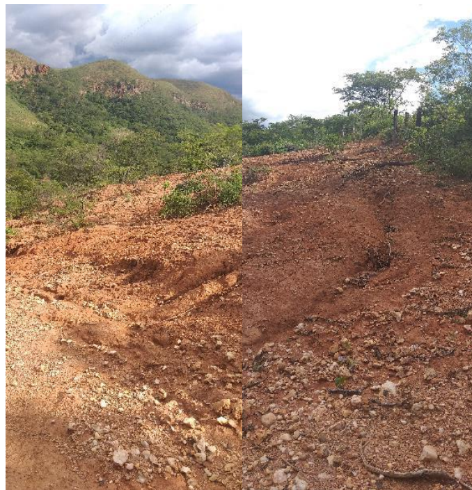
Figura 4.91 – Estrada vicinal, em estado crítico, de acesso à Propriedade 43
