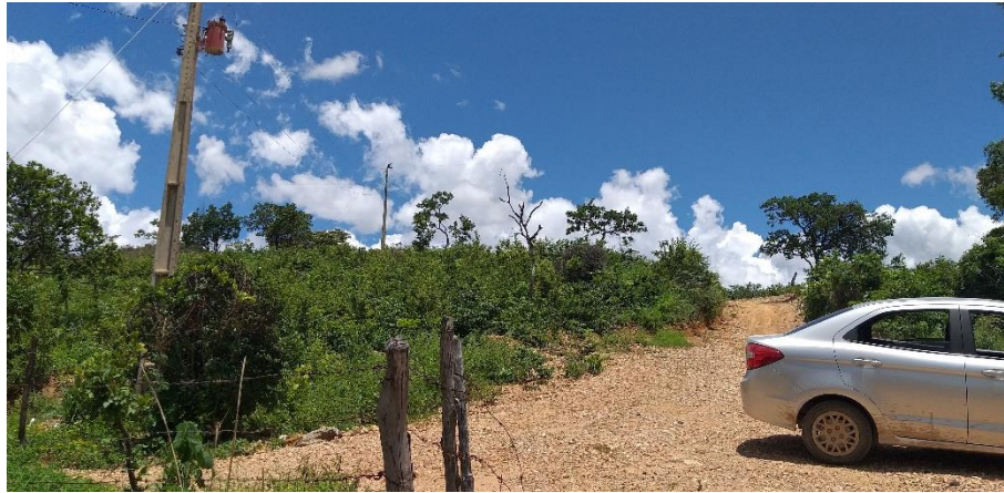
Figura 4.90 – Estrada não pavimentada, em estado crítico, de acesso à Propriedade 38
