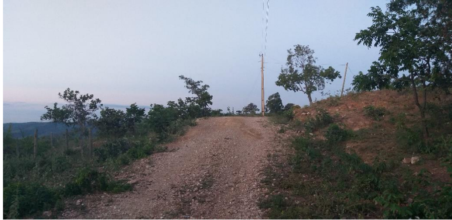
Figura 4.88 – Estrada não pavimentada, em estado crítico, de acesso à Propriedade 25
