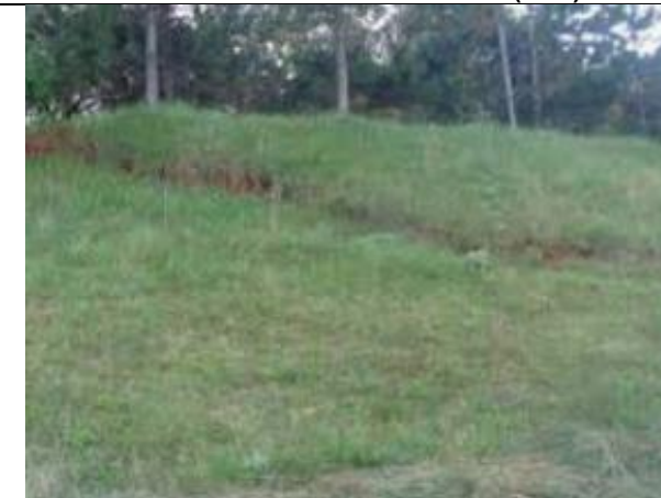
Figura 4.19 - Foto ilustrativa demonstrando uma superfície suave anteriormente desnuda já em processo avançado de cobertura vegetal com espécies herbáceas Fonte: TRIUNFO CONCEPA (2018)
