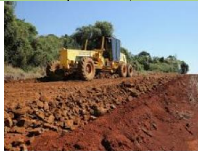
Figura 4.9 – Foto ilustrativa do trabalho de regularização da superfície com motoniveladora, em trecho de estrada de terra
