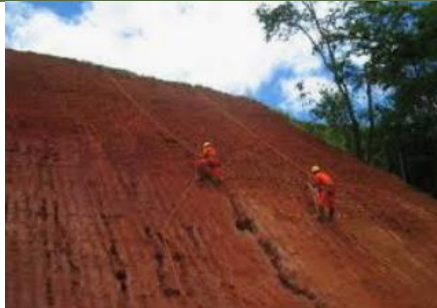
Figura 4.14 – Foto ilustrativa demonstrando a operação de coveamento em superfície de talude desnudo Fonte: LAN GEOTECNIA E FUNDAÇÃO (2020)
