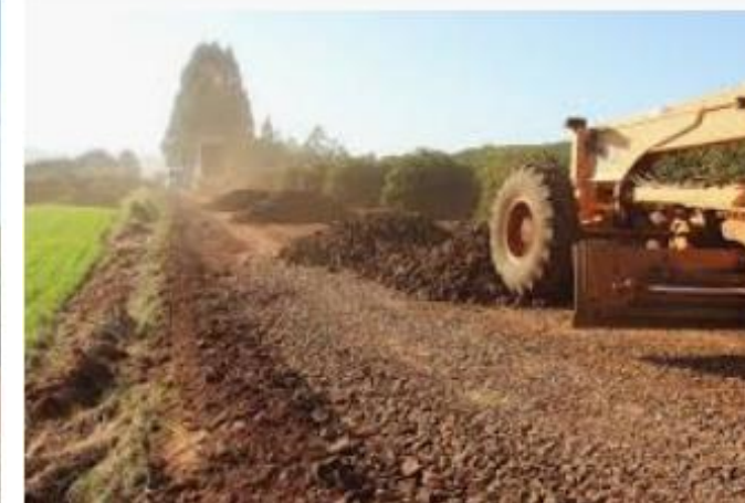
Figura 4.10 – Fotos ilustrativas do trabalho de patrol na distribuição do cascalho já lançado, num trecho de estrada de terra
