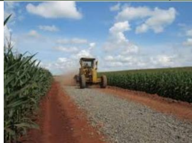
Figura 4.10 – Fotos ilustrativas do trabalho de patrol na distribuição do cascalho já lançado, num trecho de estrada de terra
