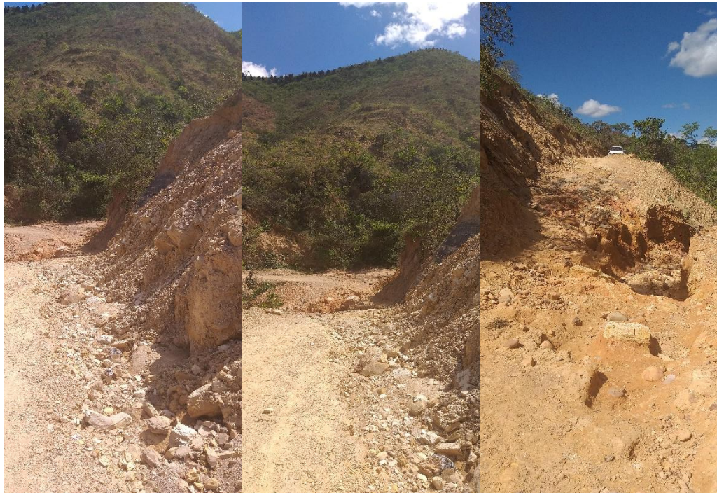
Figura 4.92 – Estrada não pavimentada, em estado crítico, de acesso à Propriedade 45
