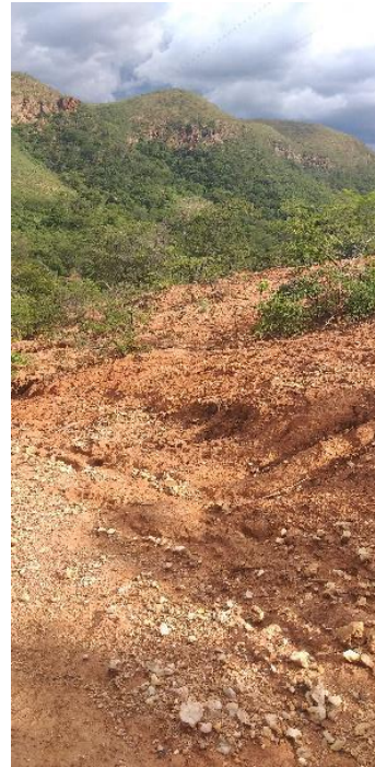
Estrada vicinal, em estado crítico, de acesso à Propriedade 43
