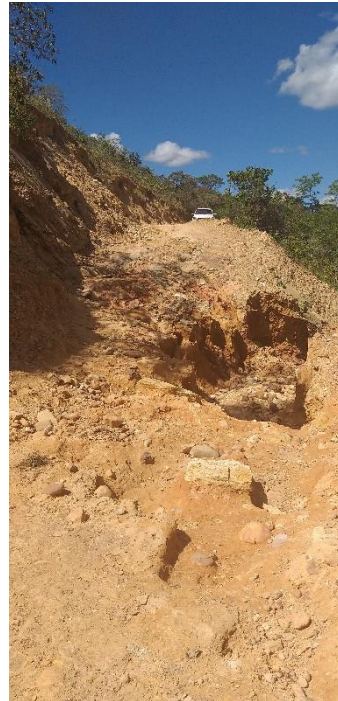
Estrada não pavimentada, em estado crítico, de acesso à Propriedade 45
