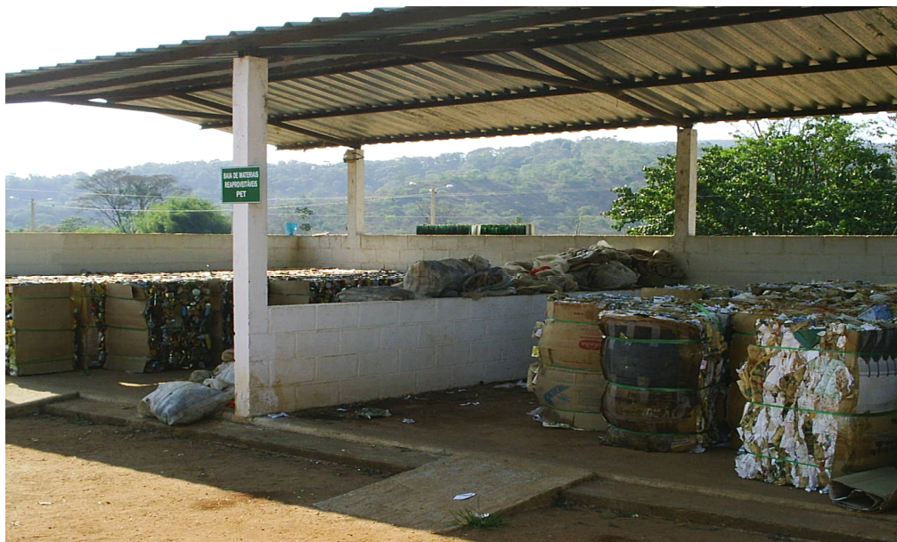
Figura 7.12 - Unidade de triagem e compostagem (UTC) – Processamento de recicláveis. Fonte: FEAM.
