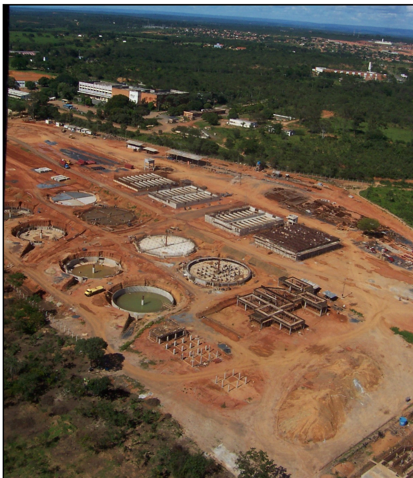
Figura 7.7 – Estação de tratamento de esgoto de Montes Claros.
