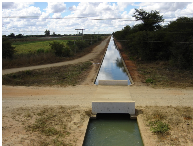
Figura 6.16 – Perímetro Jaíba Etapa I – Canal.
