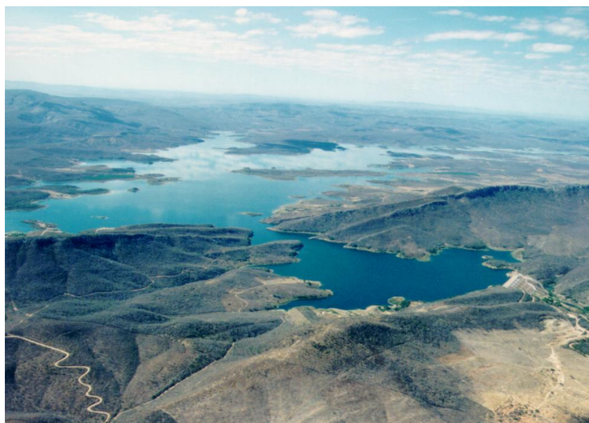
Figura 6.15 – Captação Barragem Bico da Pedra.
