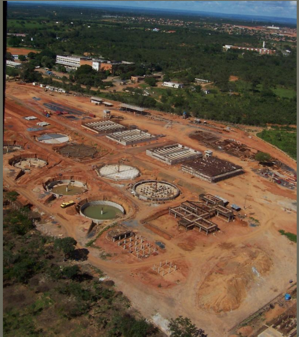
Estação de tratamento de esgotos de Montes Claros.
