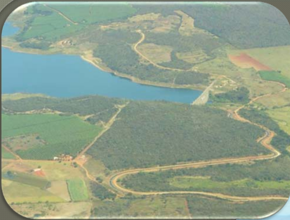
Barragem da Captação, no Rio São Francisco
