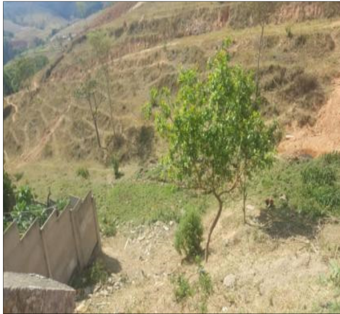
Figura 41: Lançamento de esgoto na rua Major Belizário Fonte: PRO BRAS, 2017
