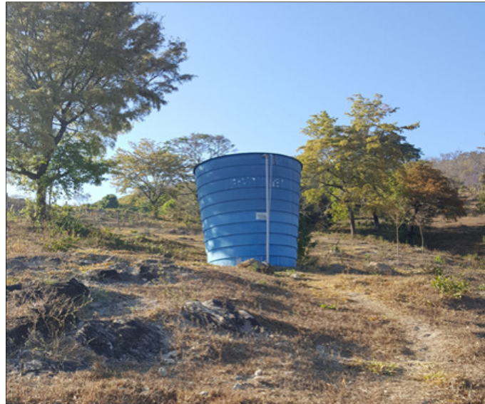
Figura 30: Reservatório de água – comunidade Joaquim Rodrigues 1 Fonte: PRO BRAS, 2017
