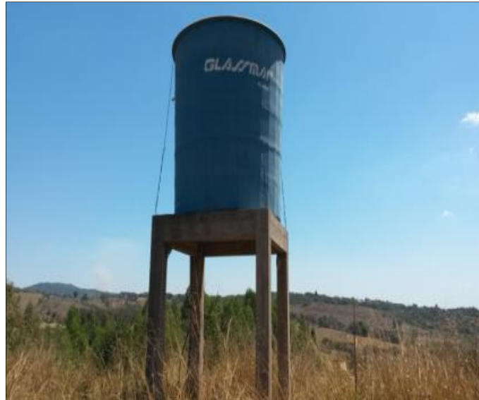
Figura 28: Reservatório de água - comunidade Costas Fonte: PRO BRAS, 2017
