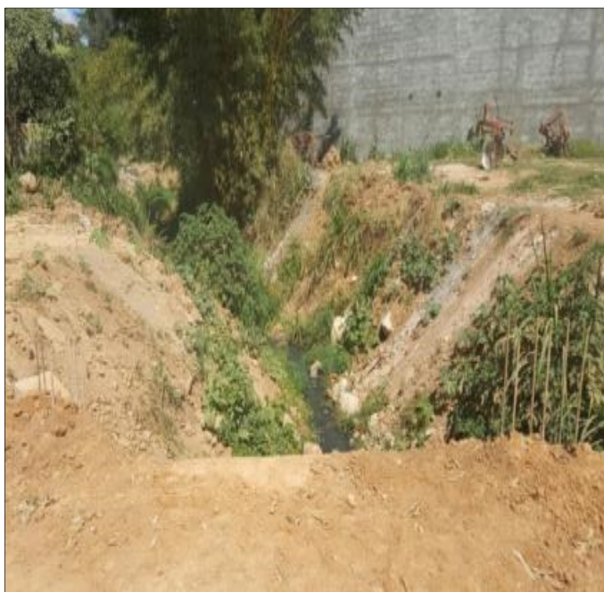
Figura 95: Córrego receptor da drenagem pluvial, passando nos quintais das casas Fonte: PRO BRAS, 2017
