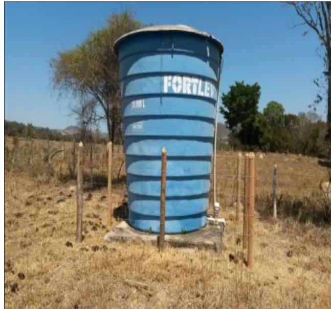
Figura 22: Reservatório - comunidade Aguada
