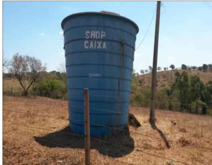
Figura 26: Reservatório de água - comunidade Correias Fonte: PRO BRAS, 2017
