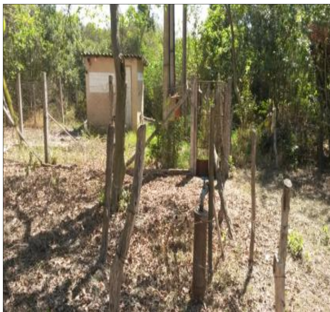
Figura 36: Captação de água subterrânea – comunidade Tatu
