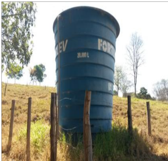
Figura 24: Reservatório - comunidade Cachoeirinha Fonte: PRO BRAS, 2017
