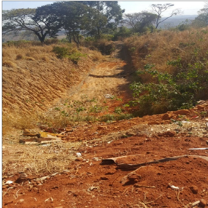
Figura 88: Vala de rejeitos Fonte: PRO BRAS, 2017
