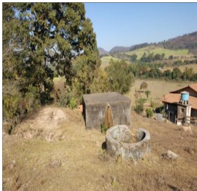
Figura 31: Reservatório de água – comunidade Joaquim Rodrigues 2 Fonte: PRO BRAS, 2017
