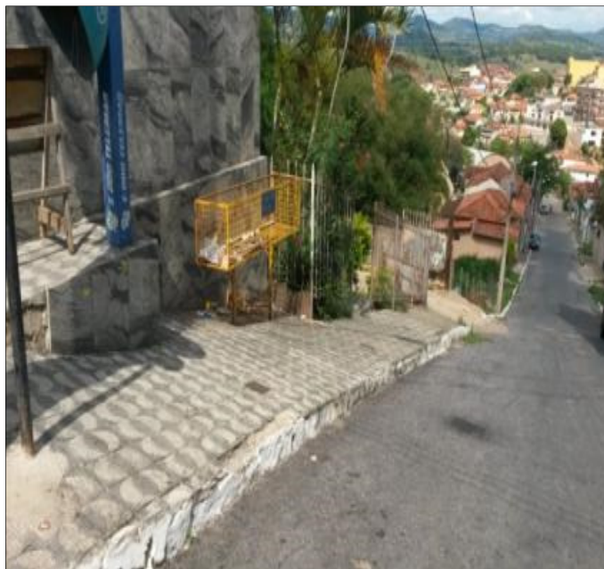
Figura 52: Lixeiras utilizadas para o acondicionamento dos resíduos Fonte: PRO BRAS, 2017
