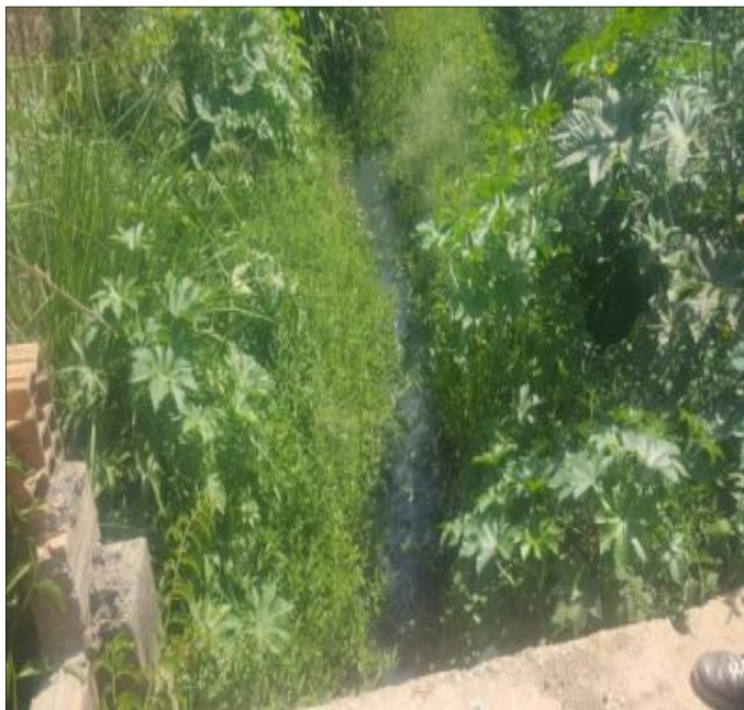
Figura 94: Córrego receptor da drenagem pluvial, passando nos quintais das casas Fonte: PRO BRAS, 2017
