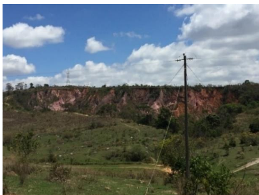
Figura 2 - Voçorocas na Área de atuação do Projeto - Ponto 1 Fonte: Consominas, 2019
